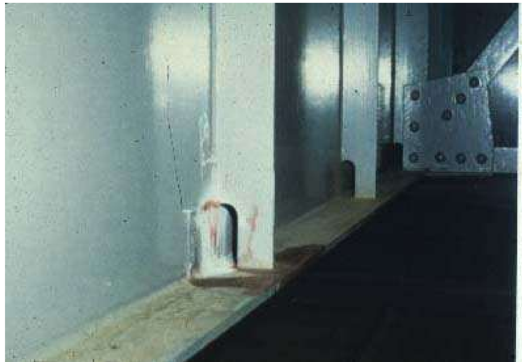
列車の高速走行による共振現象 一一補強対策 TIG dressing 30000か所
