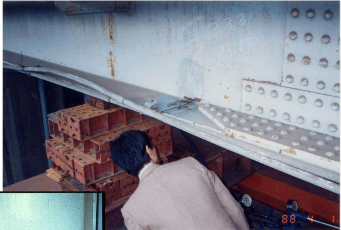
下フランジ板継ぎ溶接に残された 未溶接部からの疲労亀裂
