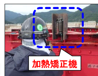
既設変形部材の加熱矯正
