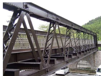
鉄道橋から公園内に移設 明治時代に建設されたトラス橋
