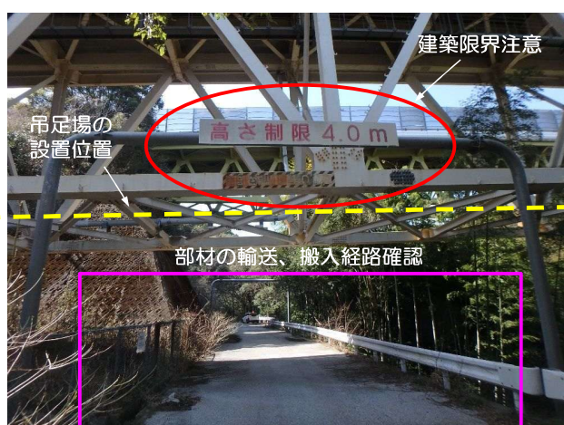
部材の輸送や搬入経路確認 施工箇所の状況確認(建築限界注意)
