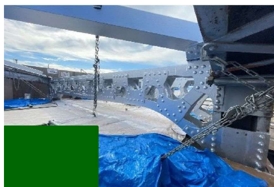
新設橋門構設置完了(意匠性を再現)
