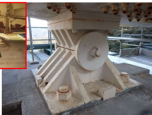
既設鋼製支承(施工前)
