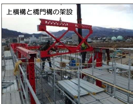
上横構と橋門構の架設
