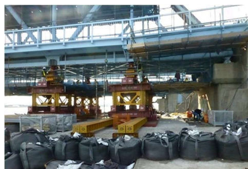
ジャッキアップ設備
