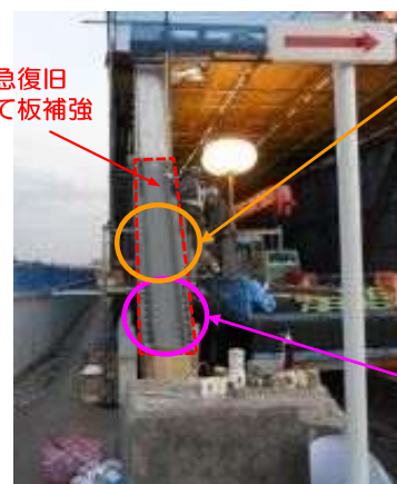
応急復旧状況
