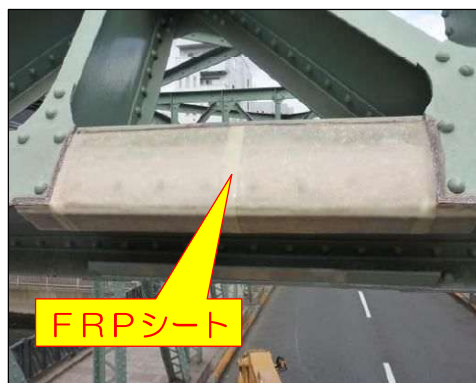
FRPシート設置
