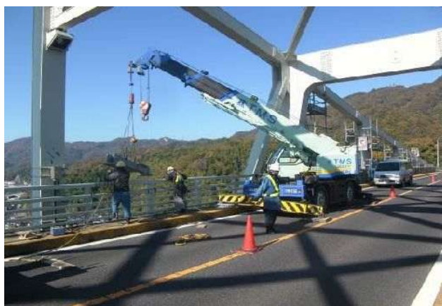
片側交通規制（部材取り込み状況）
