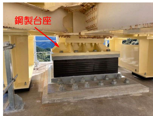
新設ゴム支承(施工後)
