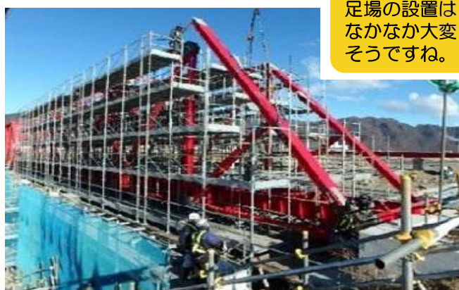
足場状況(主構)
