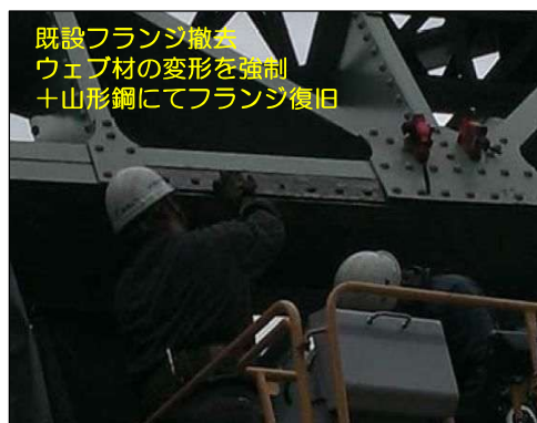
山形鋼の取付け
