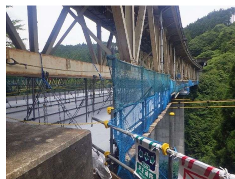
足場状況(下弦材・下横構)
