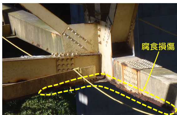
腐食損傷 (①格点部)
