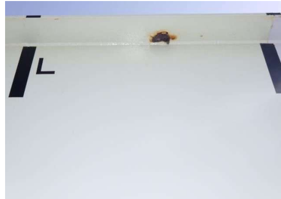
腹板側面: 全体的に健全
