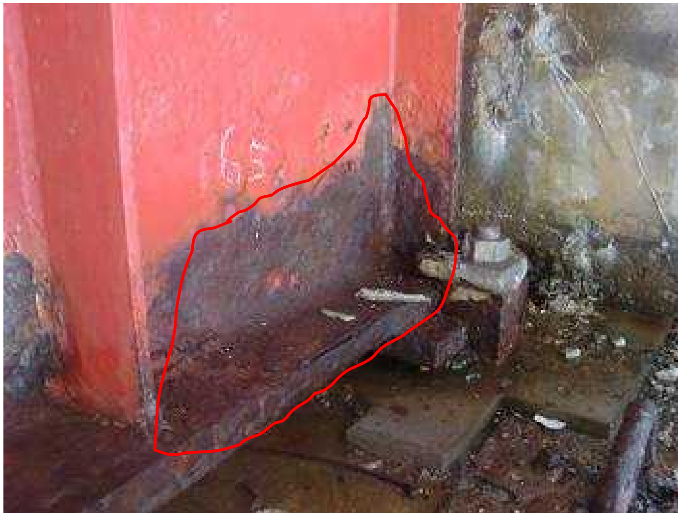
【桁端部の腐食状況の例】
