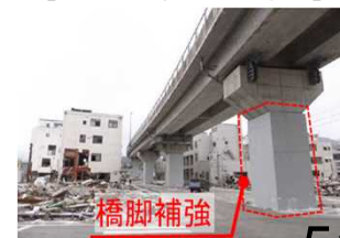
耐震補強例(釜石高架橋)
