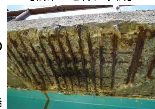
床版鉄筋の露出
