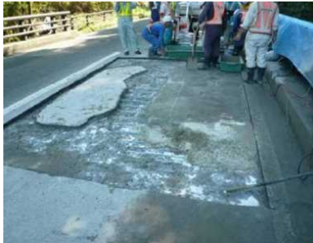
【舗装切削後の状況の例】
