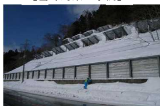
雪崩対策の例(雪崩防止柵)
