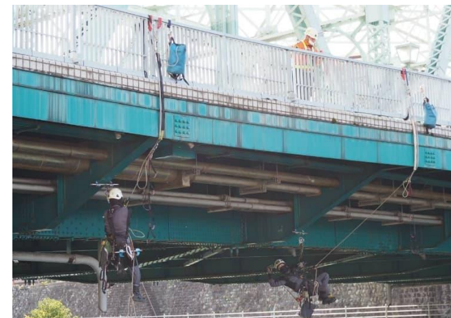
ロープアクセスによる近接目視点検
