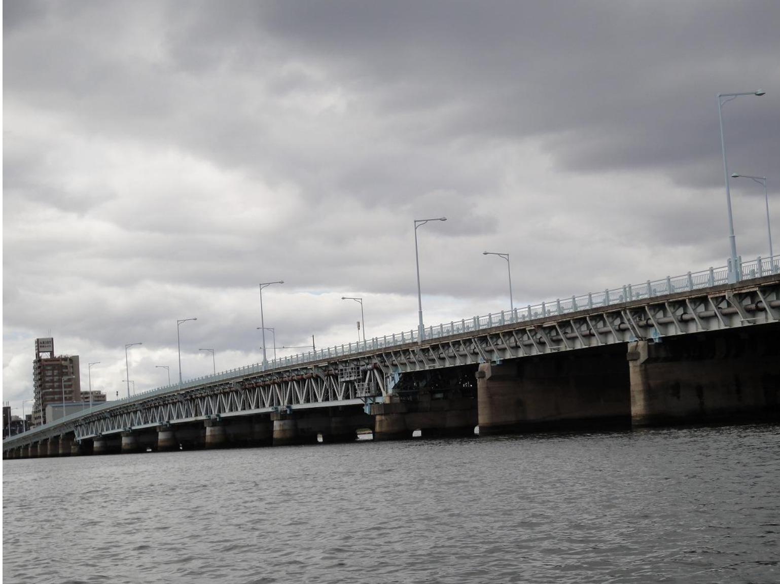
淀川大橋（国道2号）
