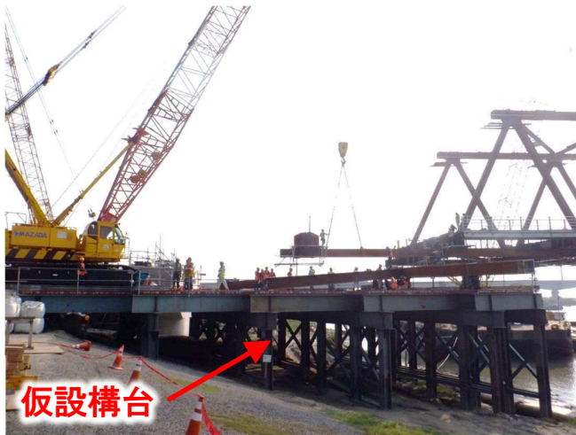
護岸近傍での架設状況（東工区）
