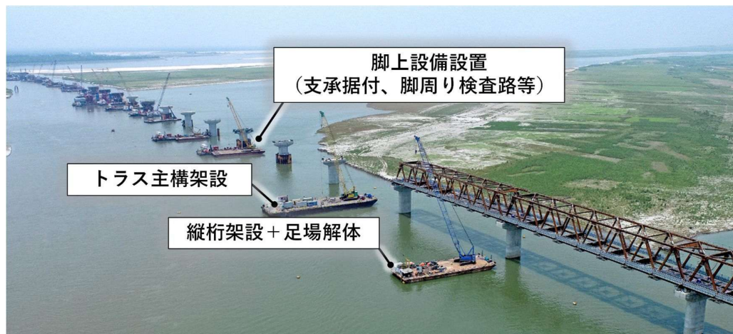
橋梁架設の船団配置状況
