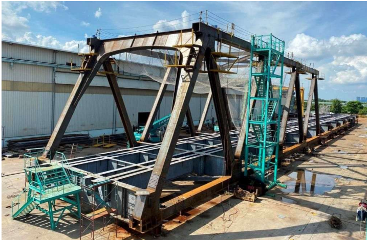
全体立体仮組の状況
