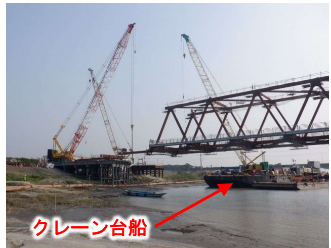
護岸近傍での架設状況（東工区）
