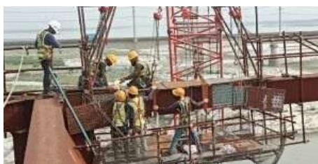
仮設材取外し状況
