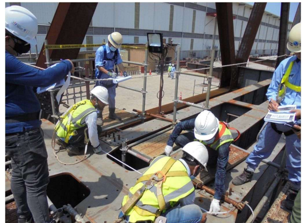
締結装置固定ボルト孔の検査状況
