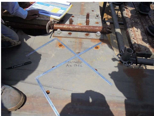
締結装置固定ボルト孔の検査状況
