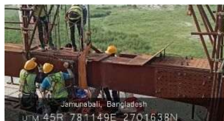
本設材取付状況
