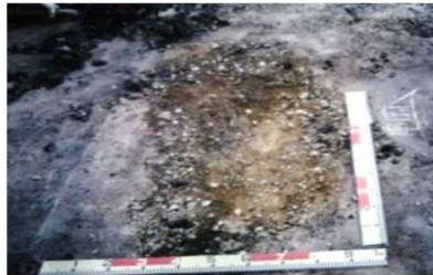
床版上面土砂化・塩害
