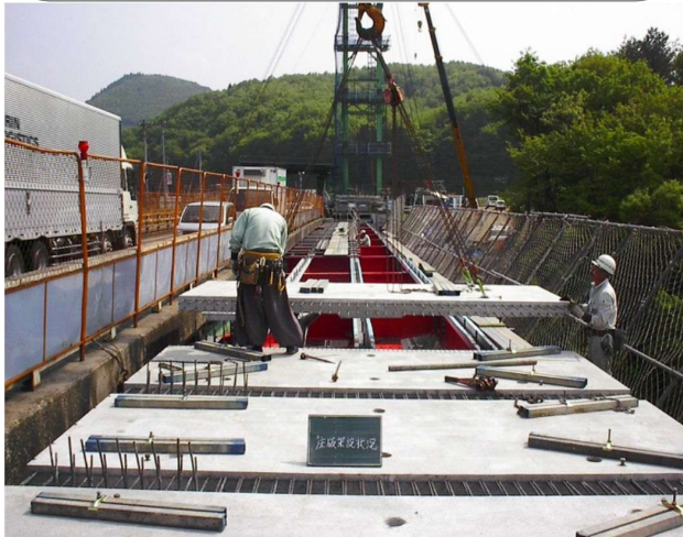
プレキャストPC床版架設状況
