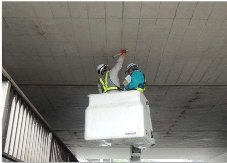
(写真はコンクリートハンマによるたたき調査)
