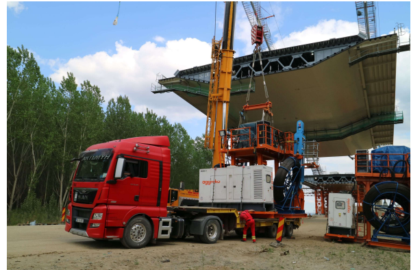
クレーンによるジャッキユニット吊上げ
