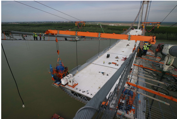
専用設備によるジャッキユニット降下
