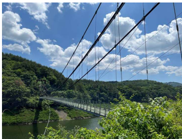
1955年竣工 重床式吊橋(人道橋)
