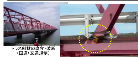
トラスガセットプレートの局所腐食
