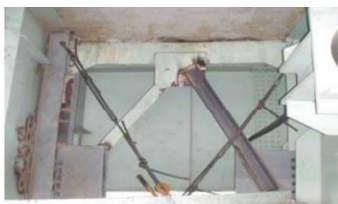
応急復旧後の端対傾構
