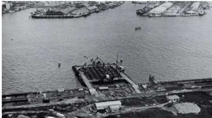
築 港 側 P11 (写真奥)
