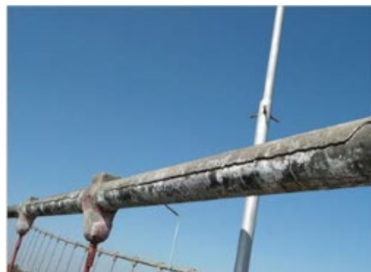
Yar Yamaung吊橋(1999)のメインケーブルの腐食@ミャンマー
