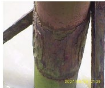
Bailey橋の鋼桁ならびに鋼製パイプ脚の腐食@ミャンマー(イラワジデルタ地帯)
