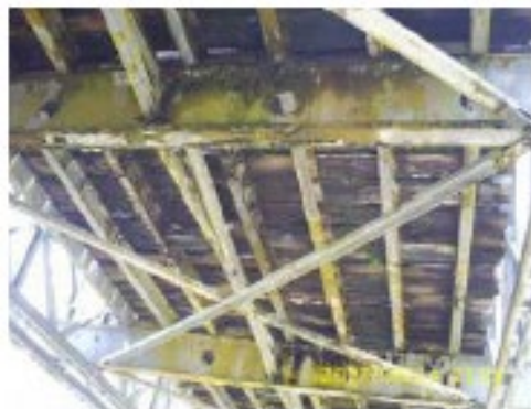
Bailey橋の鋼桁ならびに鋼製パイプ脚の腐食@ミャンマー(イラワジデルタ地帯)
