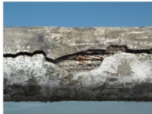
Yar Yamaung吊橋(1999)のメインケーブルの腐食@ミャンマー
