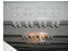
高力ボルトを用いた補修例
