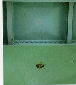
写真⑨バックルプレートの小穴
