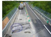
欠損部詳細 (はつり完了)
