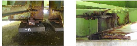
腐食が進行すると、鋼部材が腐食により欠損する場合もある。
