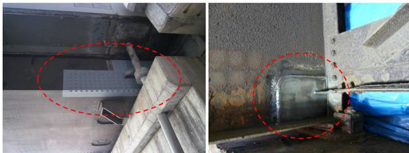
ボルト接合による当て板補修の例
