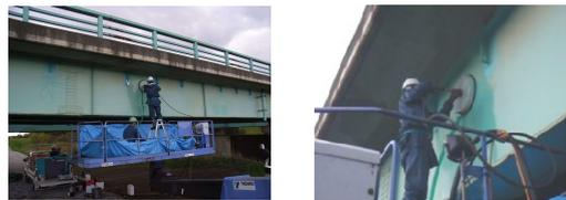
◇ 予防保全の一つの方法として、橋梁部材に付着した汚れや塩分などを取り除き、できるだけ架設初期の状態に近づけて、橋梁全体の腐食寿命を延ばすことを目的とした対策。
