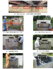
写一解 12.2.11 支承交換における制御破砕工法の検証実験
