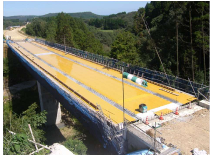
固定式支保工工法 解説の充実
