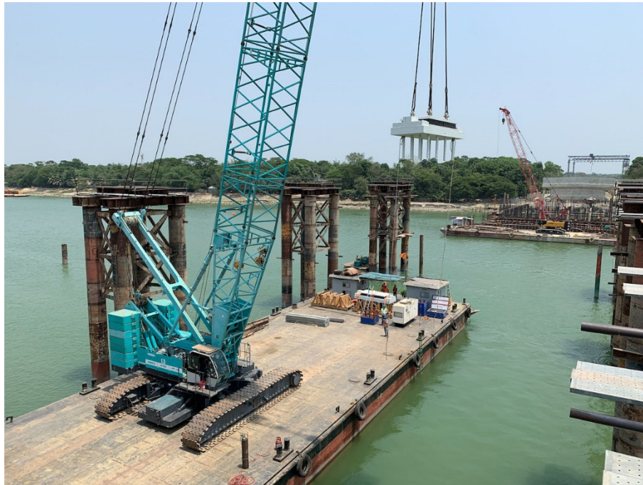
支承の吊り上げ
