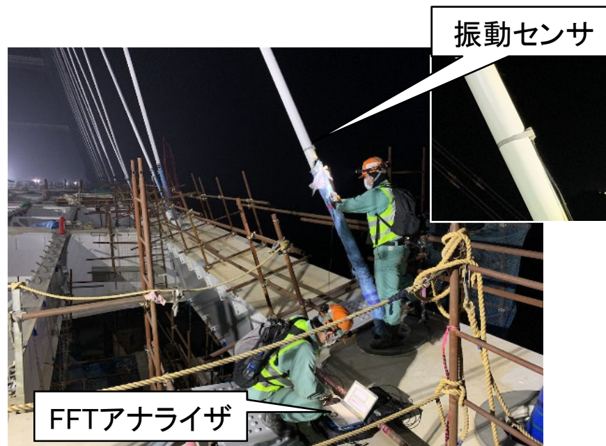
振動法による張力測定
