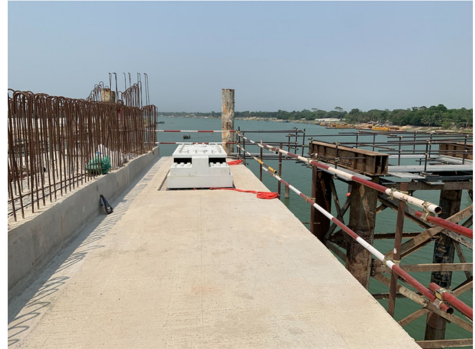
支承の仮据付け
