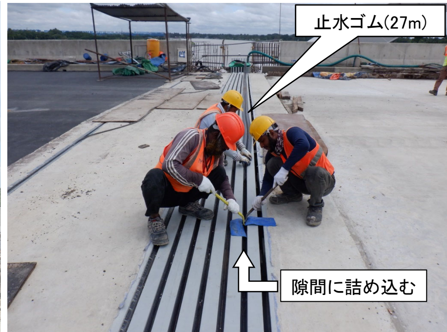
止水ゴムの挿入作業
