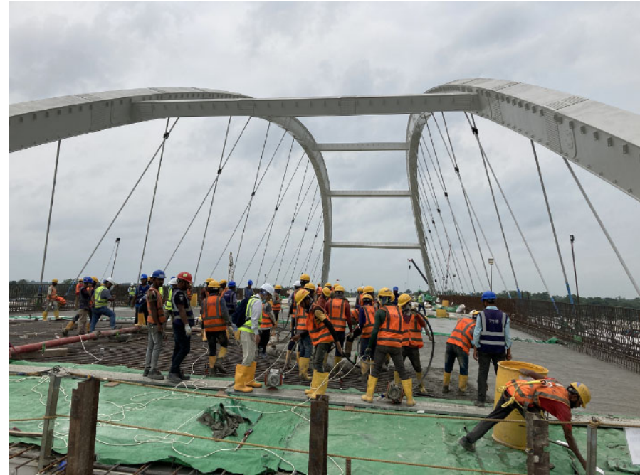
床版打設状況
