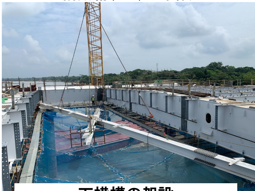
補剛桁(20t)の架設
