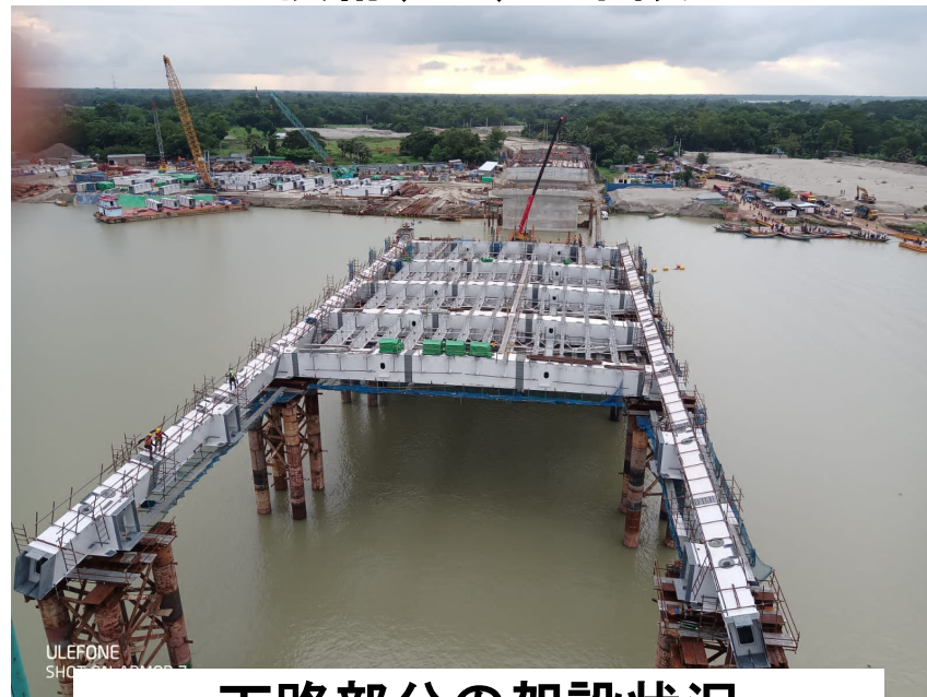
横桁(60t)の架設
