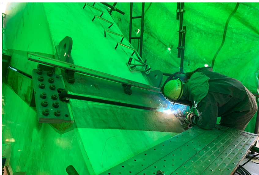
補剛桁とアーチリブのジョイント
