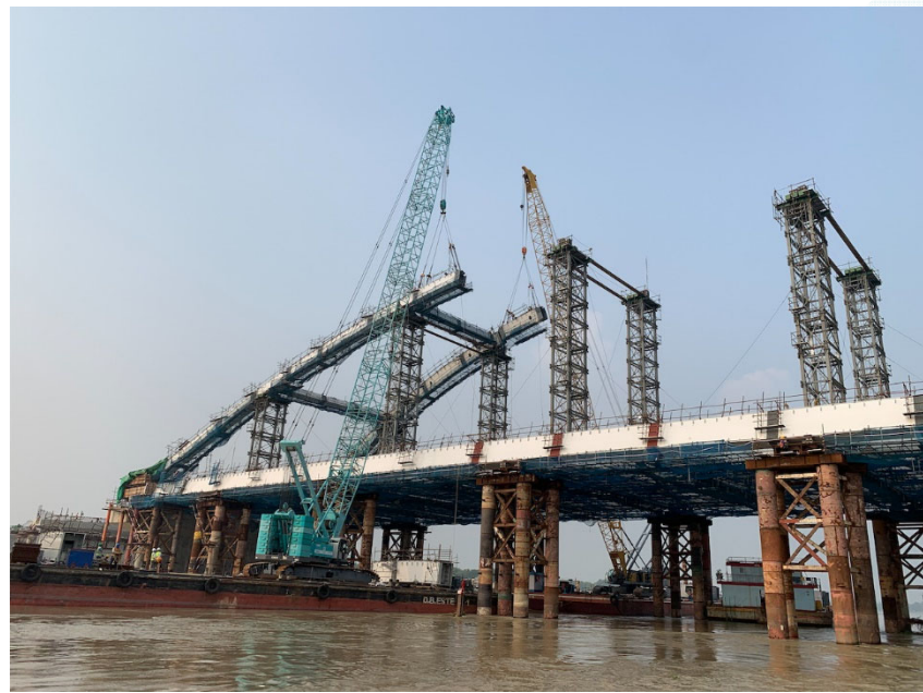
アーチリブの架設(2 段目ベント)
