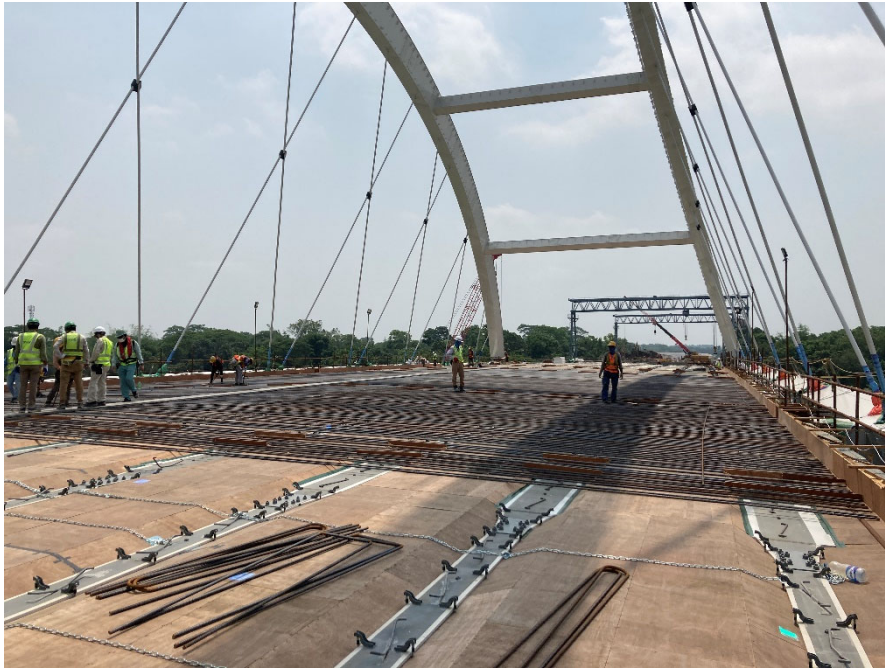
床版の配筋・型枠状況
