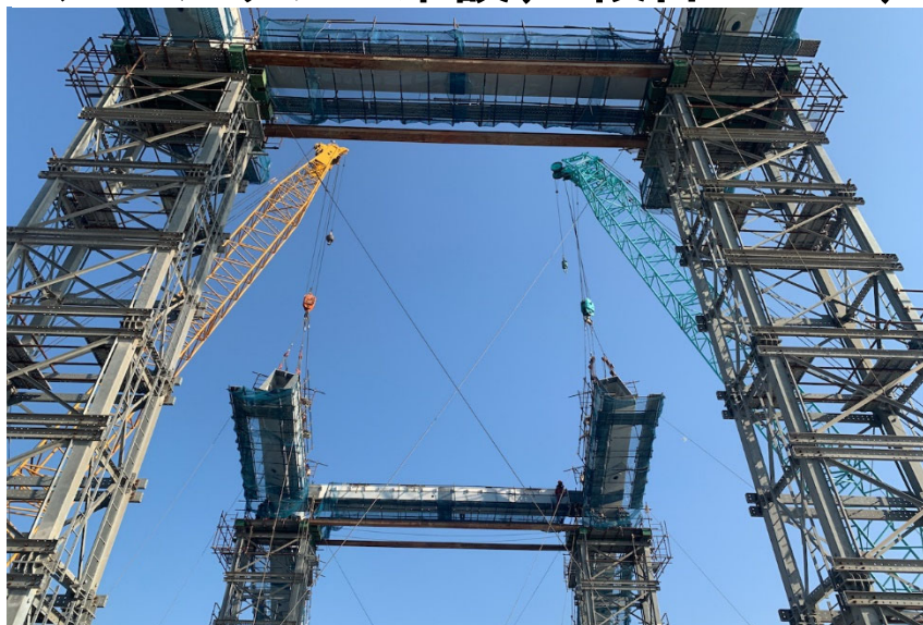
アーチリブの架設(3 段目ベント)
