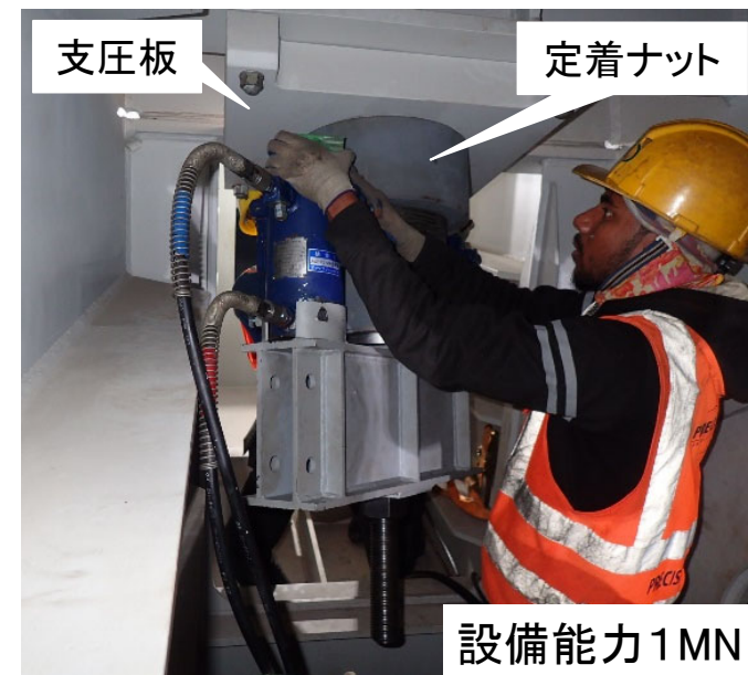
定着部にセットされた調整用ジャッキ設備
