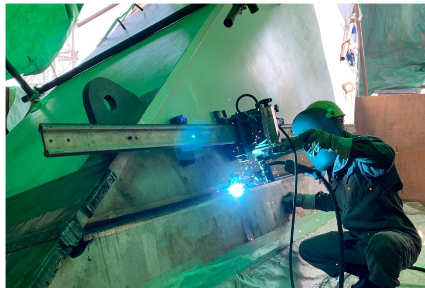
補剛桁とアーチリブのジョイント
