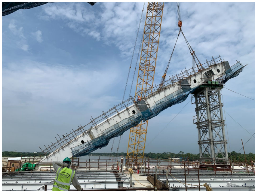
アーチリブの架設(1 段目ベント)
