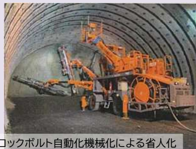
●ロックボルト自動化機械化による省人化
