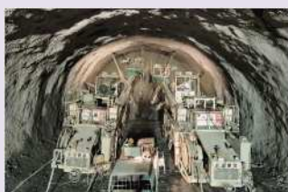
●トンネル坑内ICT技術の先駆け
