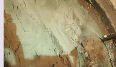
●肌落ち防止としての「鏡吹付」の標準化
