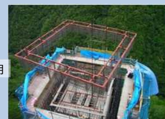
●プレハブ鉄筋技術による生産性向上
