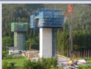
●パネル式型枠工法による急速施工
