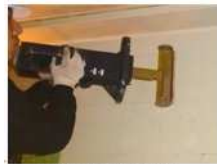
IHによる加熱状況
