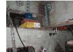
ジャッキアップによる支承取替
