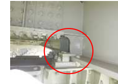
支承取替完了
