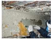
剥離剤を用いた塗膜剥離作業
