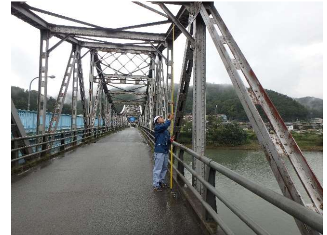
通過トラス橋高さ確認状況
