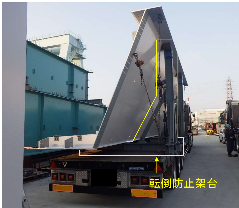
2分割の開断面箱桁の積付け
