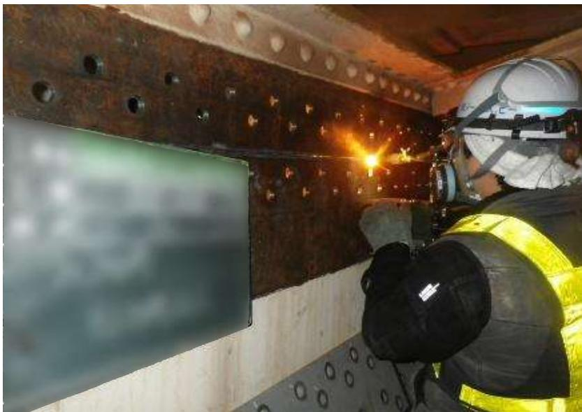
⑥縦桁ウェブ 水平切断（夜間作業）
