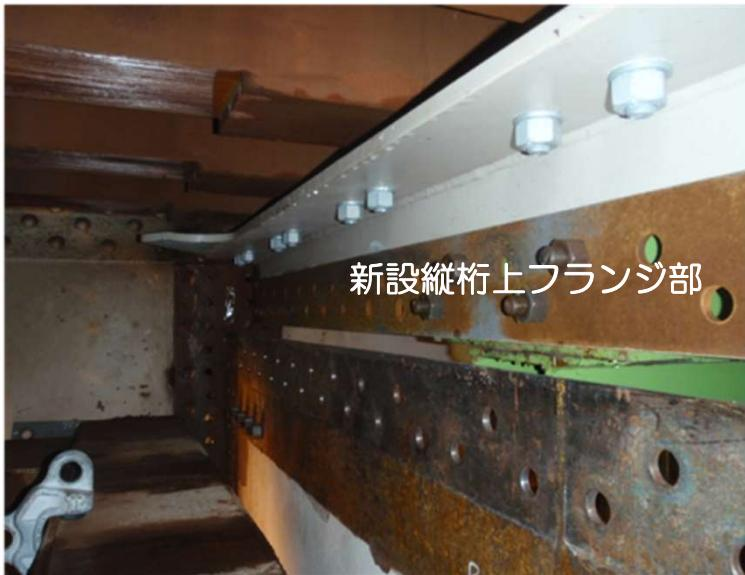
新設縦桁上フランジ部スライド、取付け
