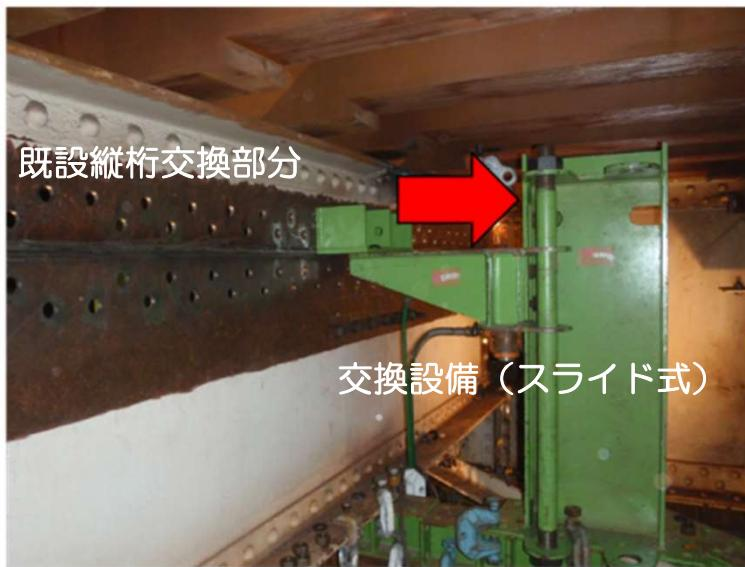
既設縦桁上フランジ部のスライド、撤去
