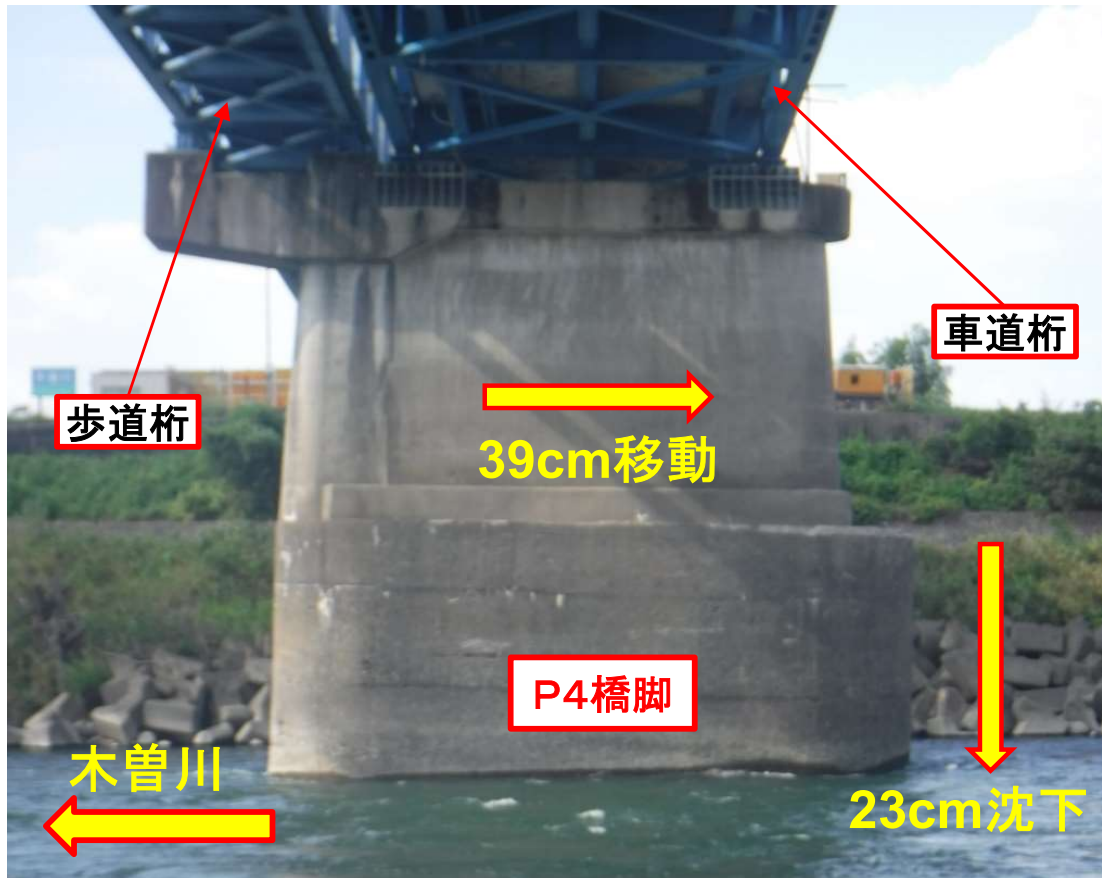
P4橋脚の傾斜状況写真
