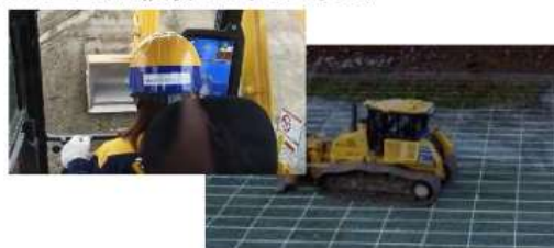
ICT建機による施工
