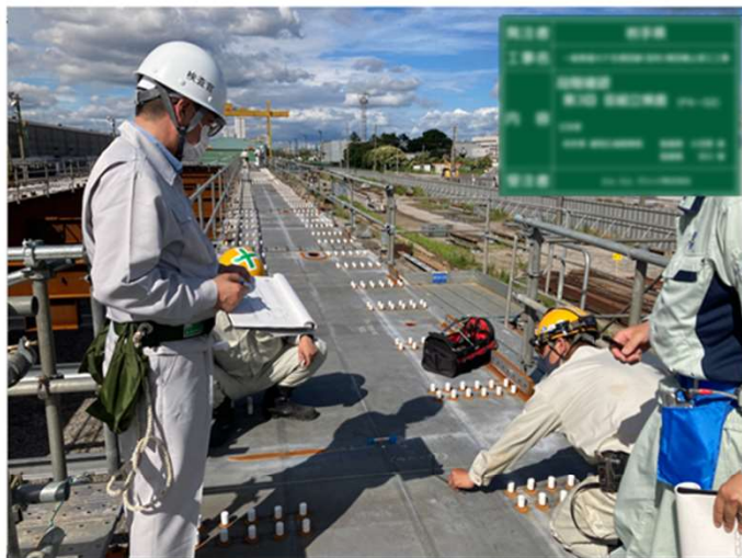
製作工場に赴いて立会検査
