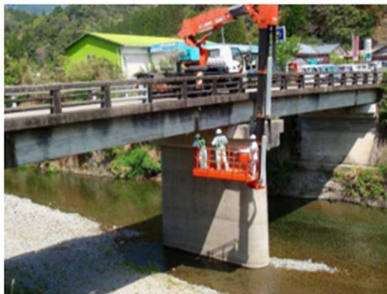
橋梁点検車による調査
