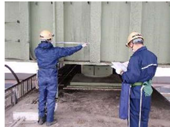
橋脚上からの近接目視
