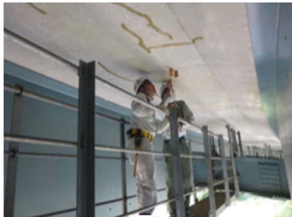
検査路からの近接目視
