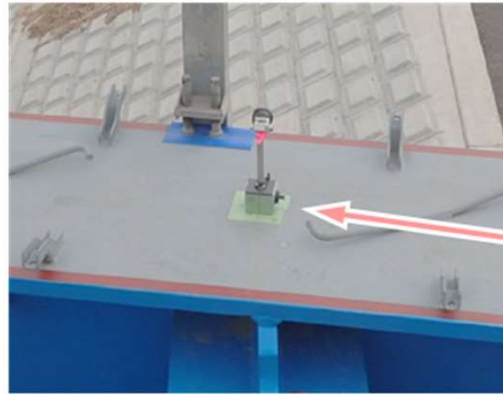
トータルステーションによる桁の出来形計測イメージ
