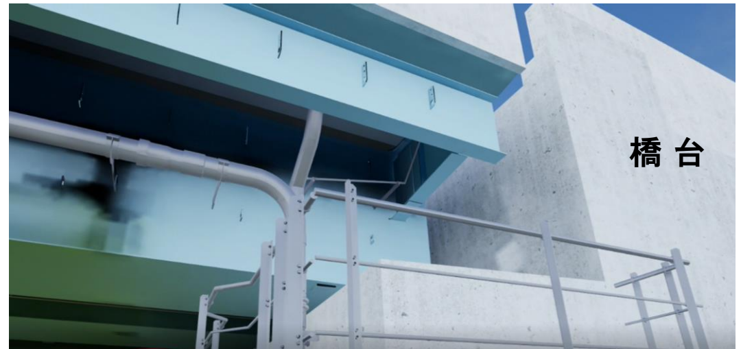
橋桁端部 (A2橋台)
