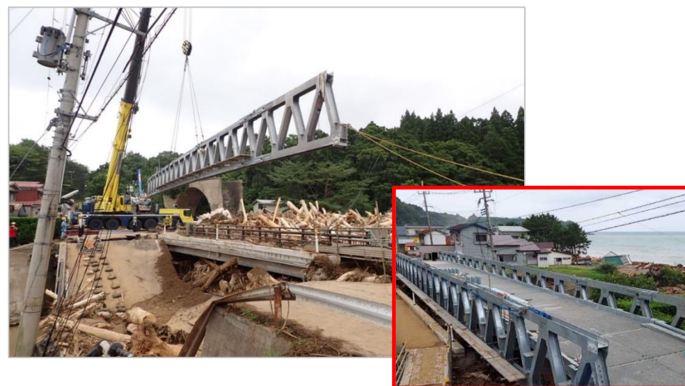
▼ 応急組立橋の架設状況
