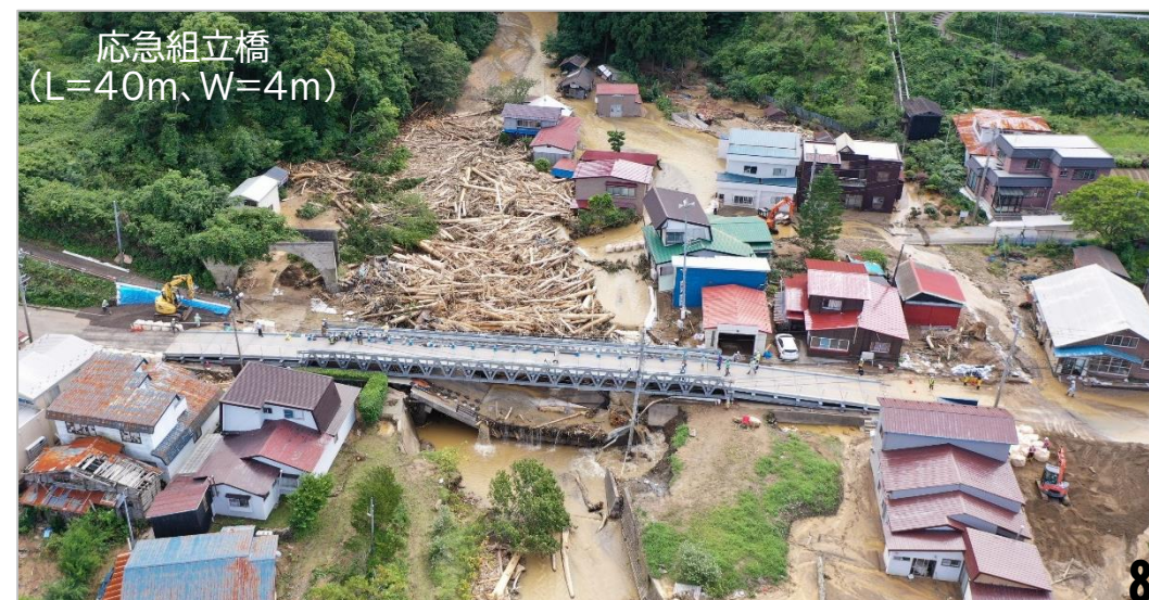
▼ 応急組立橋により交通確保
