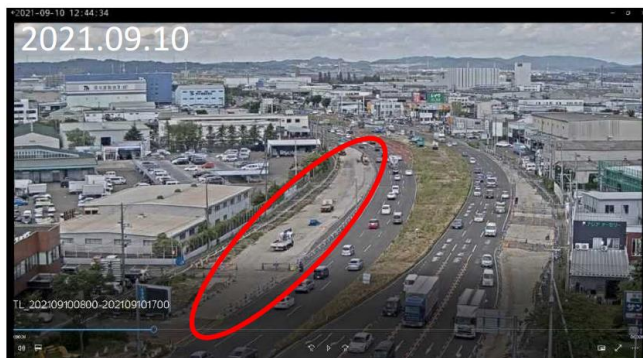
切り回し道路工事施工中
