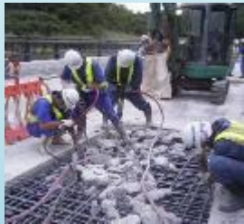
▲ 修繕・耐震補強
