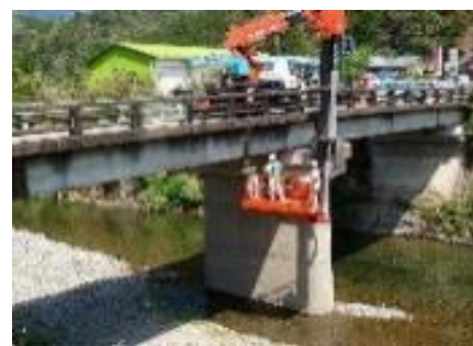
インフラの維持管理(点検作業)
