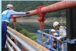
▲ 国道メンテナンス
