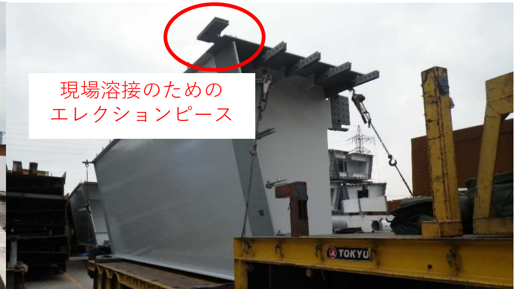
平面線形により 外側に振れている
