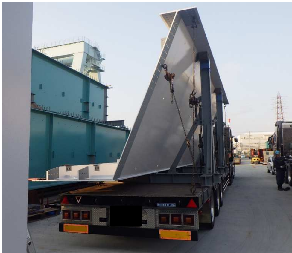
2分割の開断面箱桁の積付け
