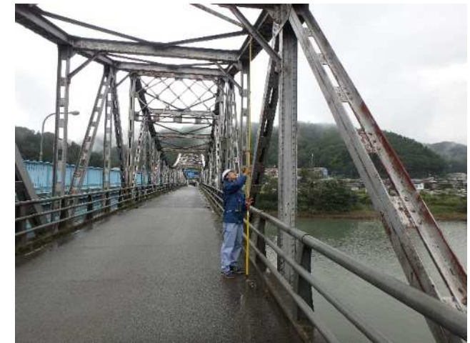
通過トラス橋高さ確認情況
