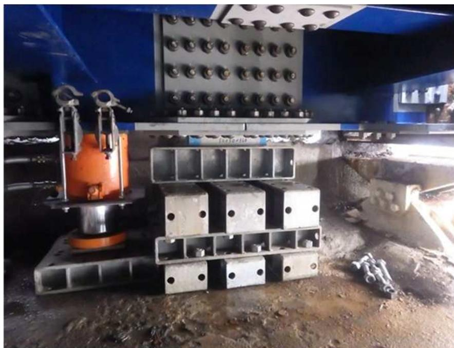
新設した横桁でジャッキアップ
