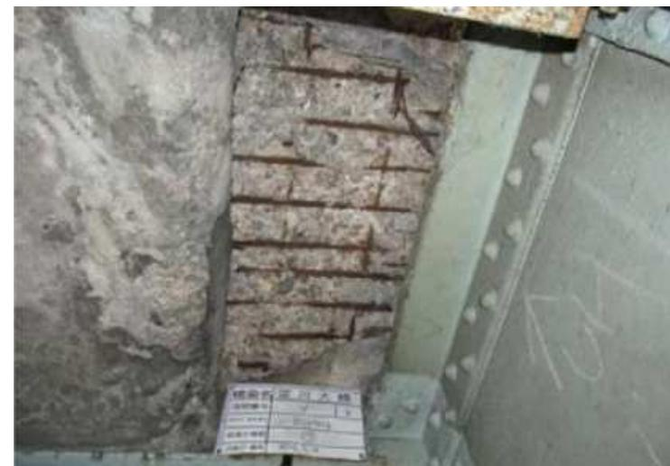
床版の剥離・鉄筋露出
