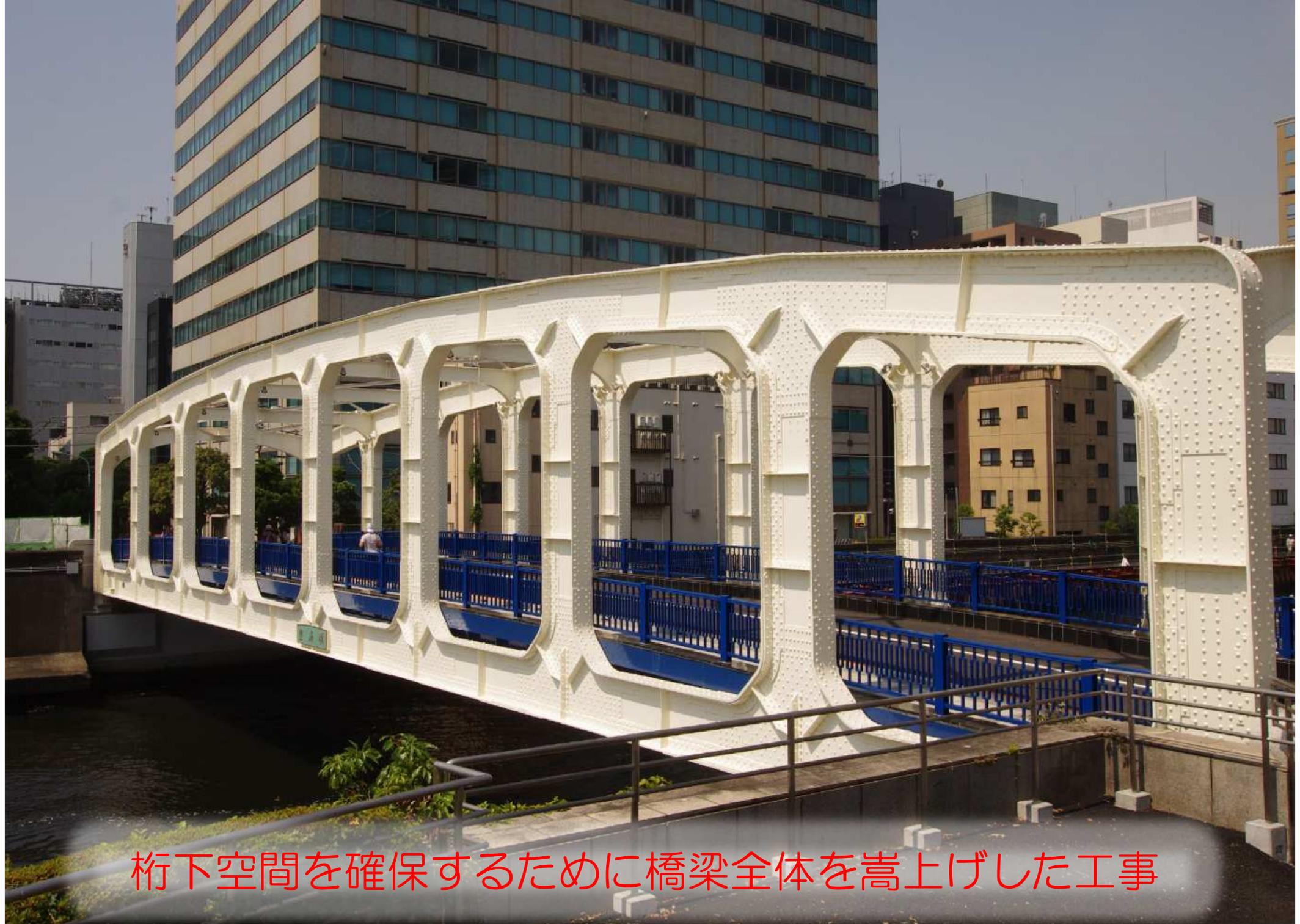
桁下空間を確保するために橋梁全体を嵩上げた工事
