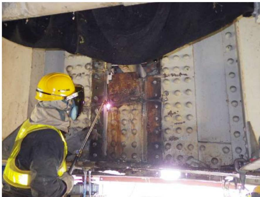
主桁腹板切断状況
