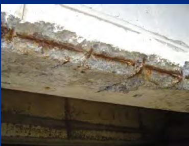
塩害による主筋の損傷部
