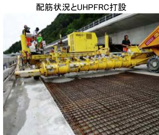
ローダーによるUHPFRC打設
