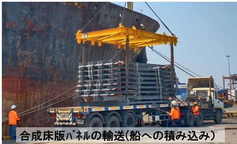
合成床版パネルの輸送(船への積み込み)
