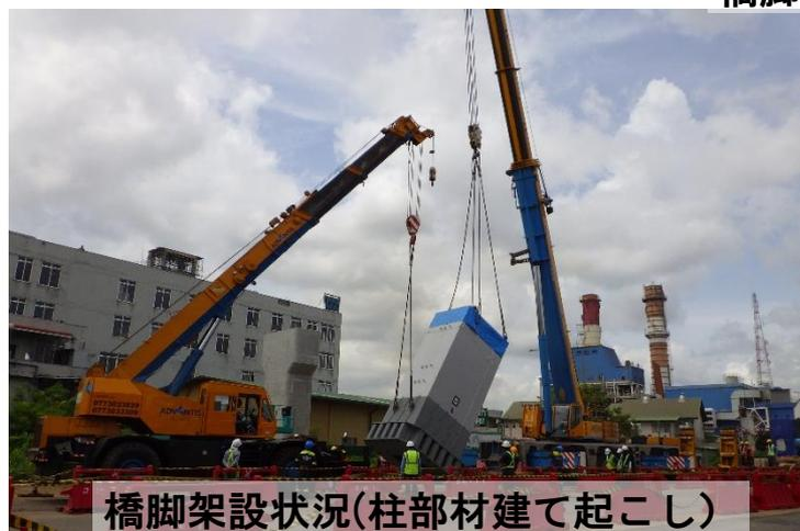
橋脚架設状況(柱部材建て起こし)
