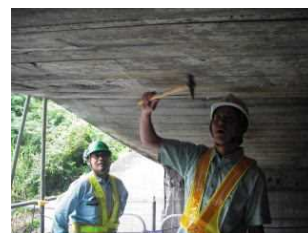
目視及びハンマーによる打音検査
