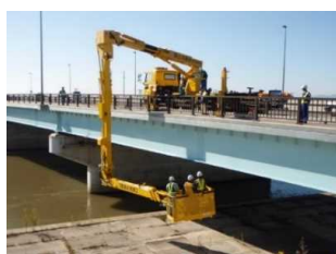
橋梁点検車や高所作業車により近接
