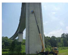
橋梁点検車や高所作業車により近接
