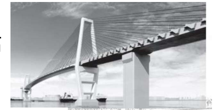
川崎港臨港大橋
