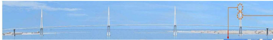
Five span cable-stayed bridge, 650m 大阪湾岸道路西伸部 (参照) 国土交通省近畿地方整備局 大阪湾岸道路西伸部経過報告、2021.9
