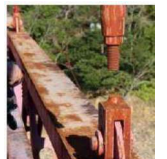
ハンガーロッドの破断
