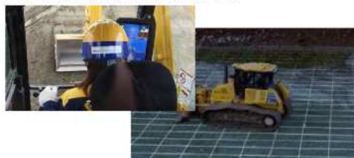
ICT建機による施工
