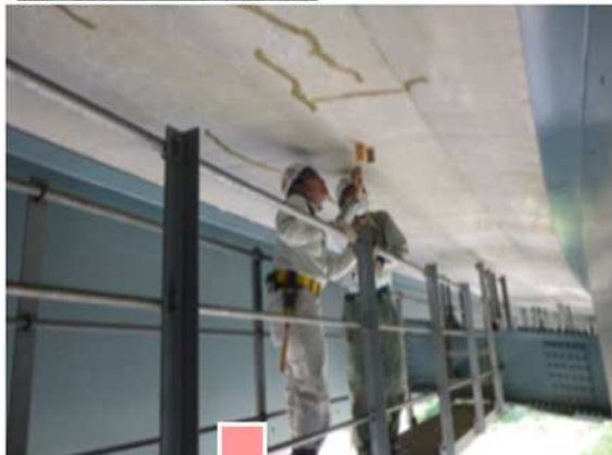
検査路からの近接目視
