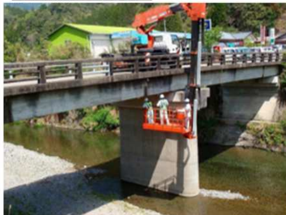
橋梁点検車による調査
