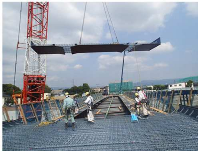
鋼板パネルの架設
