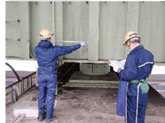
橋脚上からの近接目視
