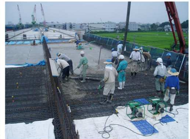
床版コンクリートの打設
