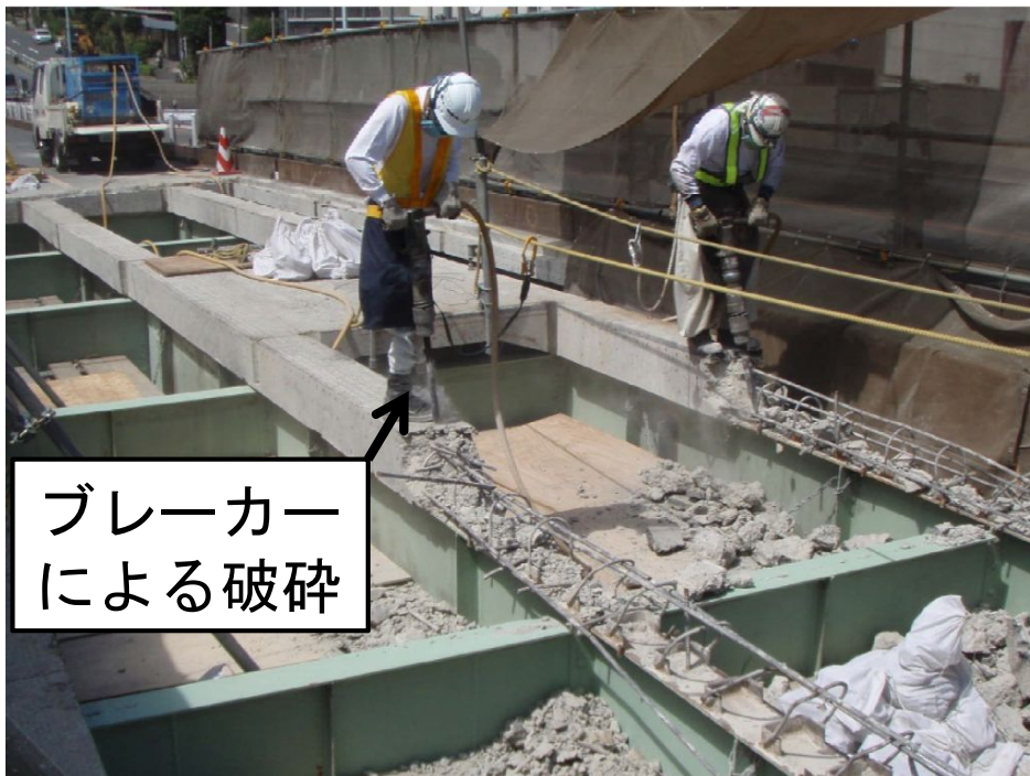
上フランジコンクリート破砕
