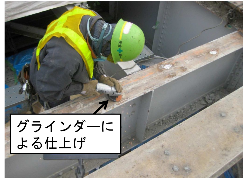
ずれ止め撤去
