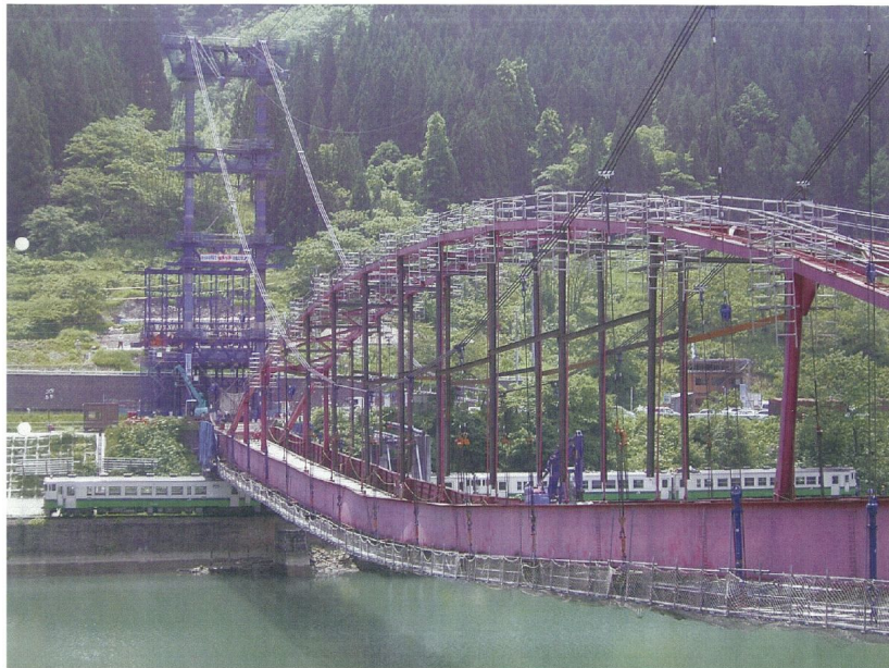
ランガー橋の床版撤去時における事故事例
