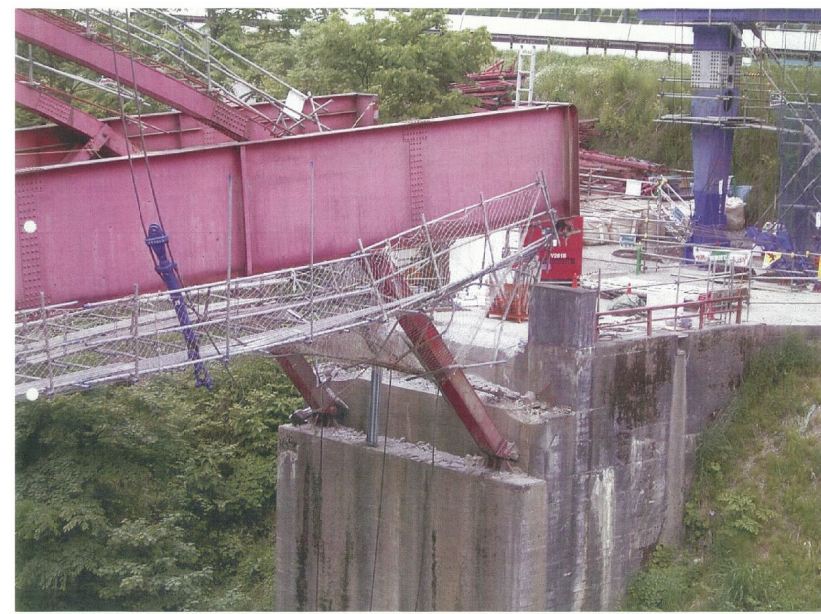
ランガー橋の床版撤去時における事故事例
