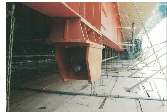
外ケーブルによる補強例
