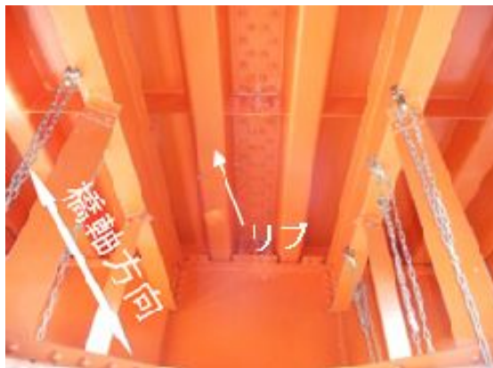
橋軸方向に配置した例
