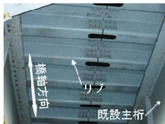
橋軸直角方向に配置した例
