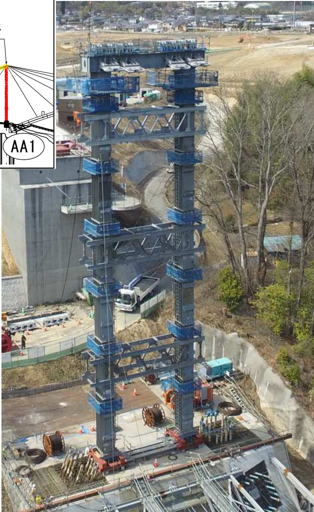
○A1側斜吊り鉄塔
