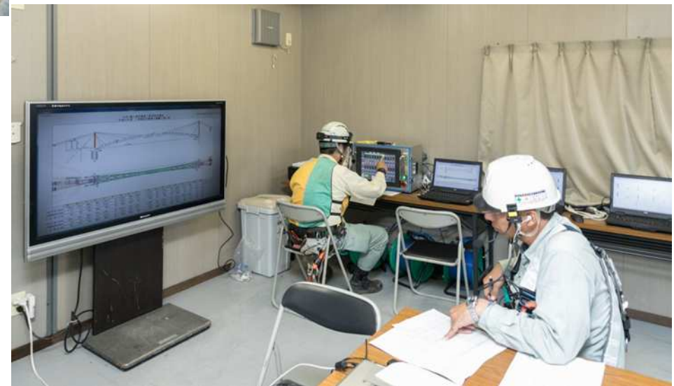
○斜吊り索集中管理操作室
