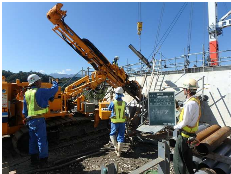
○グラウンドアンカー施工状況
