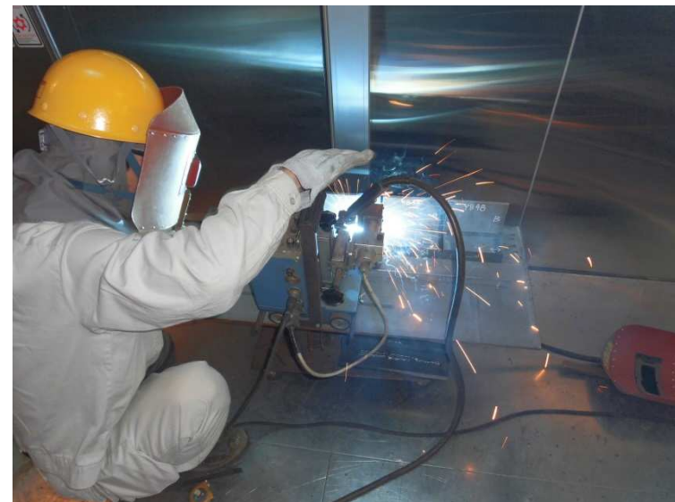
試験溶接状況
