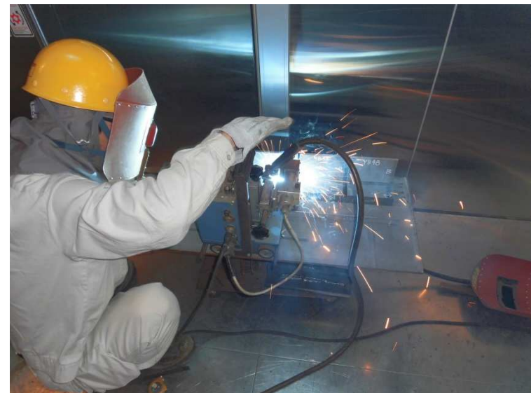
試験溶接状況
