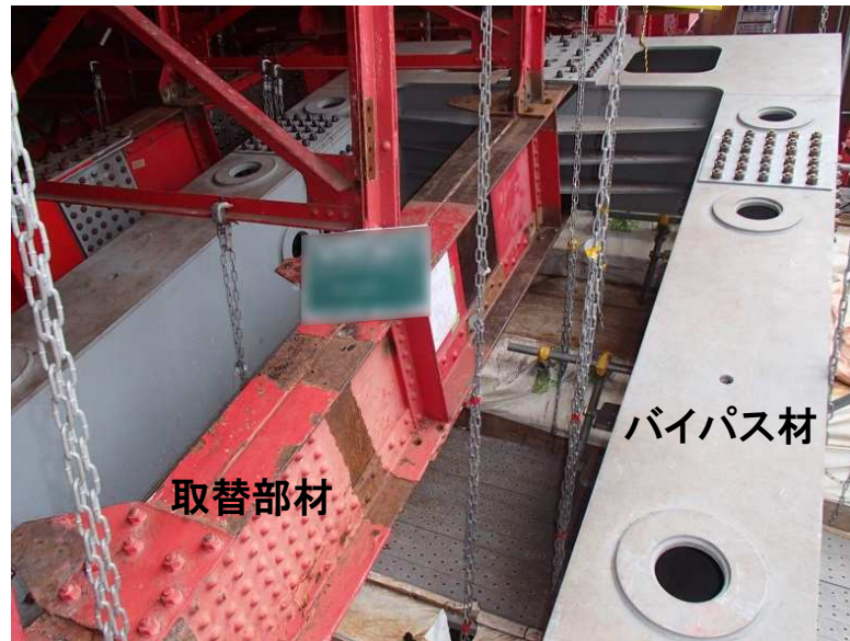
【バイパス材設置】
