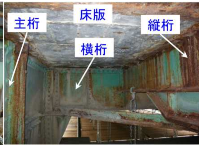
【床版下面腐食状況】
