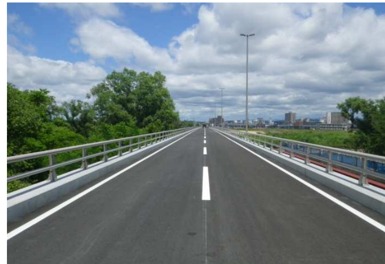
【工事完了（路面）】
