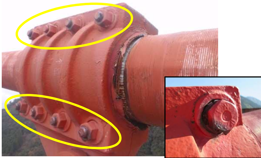
【ケーブルバンドボルト(軸力低下・塗膜劣化)】
