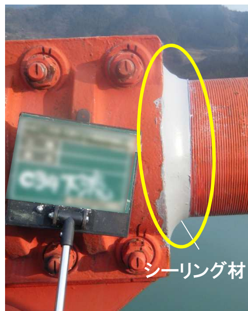
【ブチルゴムとシーリング材による防水処置】
