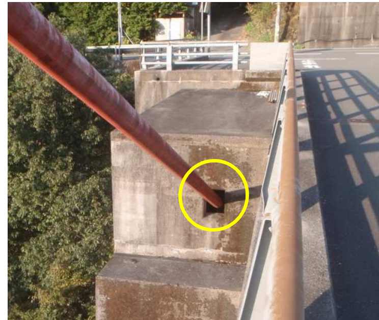
【アンカレッジ・メインケーブル 挿入部(水の入り易い構造)】
