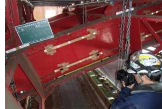
【3D計測状況】
