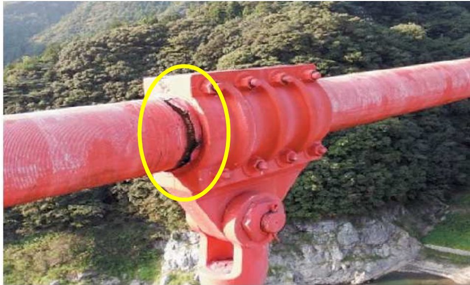
【ラッピングワイヤ塗膜劣化状況】
