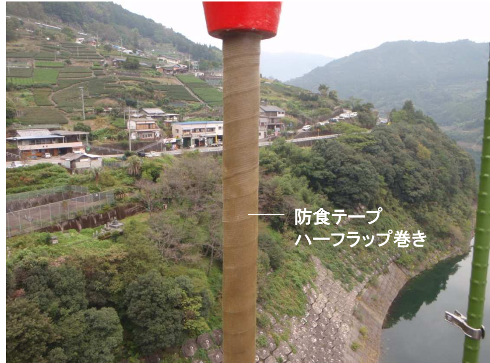
【防食テープ(ペトロラタム系)巻付け+柔軟型塗装】
