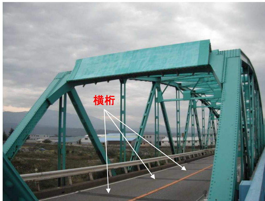
【横桁上の床版目地】
