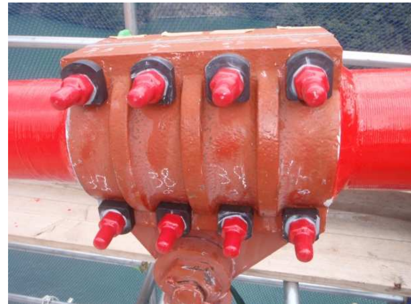
【ボルトキャップ取付状況】
