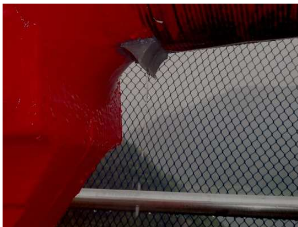
【ケーブルバンド・メイン ケーブル境界部】
