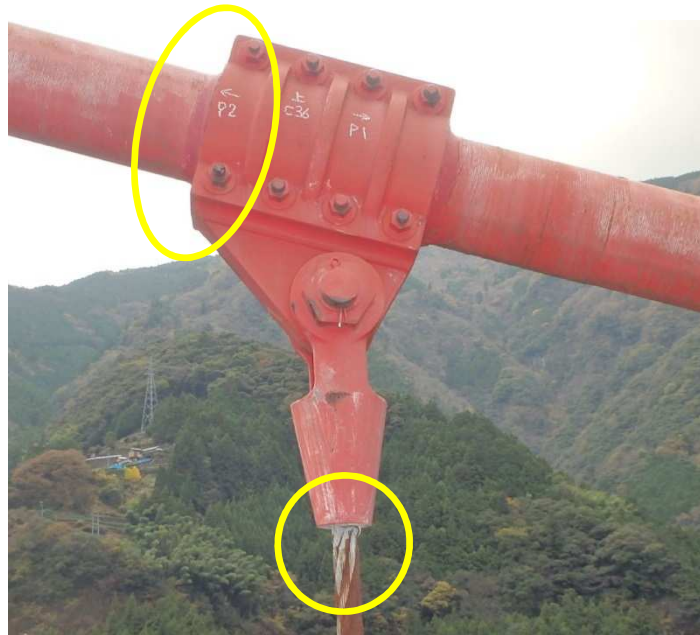
【ケーブルバンド・ハンガーロープ 境界部(水の溜まり易い構造)】
