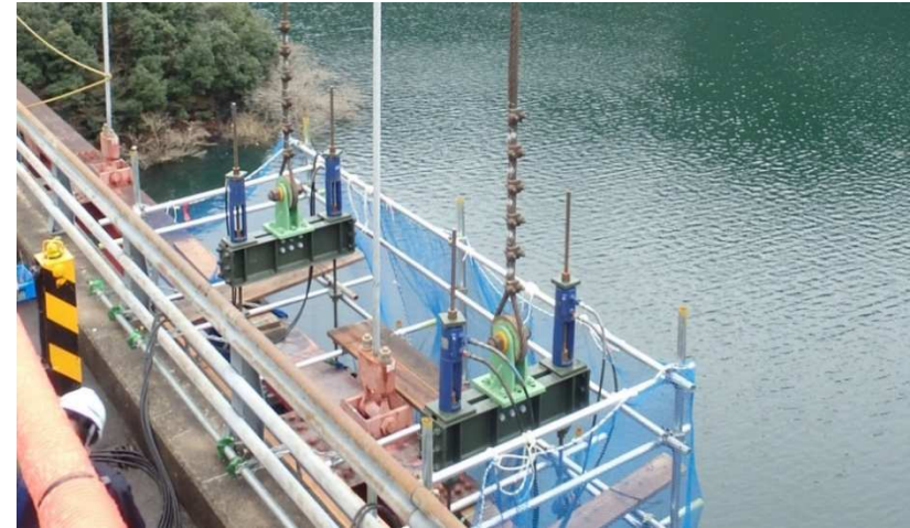
【バイパス材設置(補剛桁側)】
