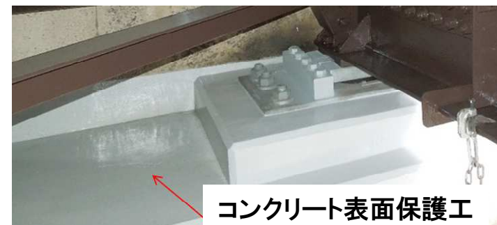
【橋台天端のコンクリート表面保護】
