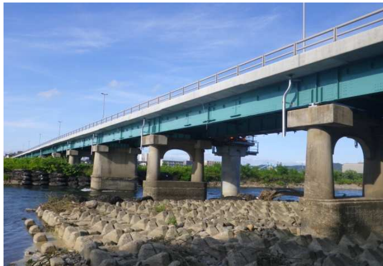
【工事完了（側面）】
