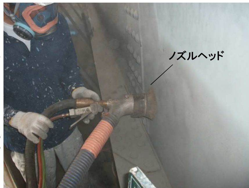
【バキュームブラスト施工状況】
