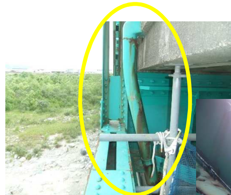
【補強部材取付完了】
