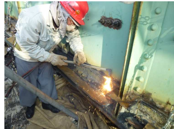
【水平補強材撤去状況】
