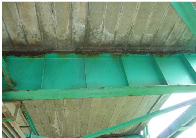
【横桁腐食状況】
