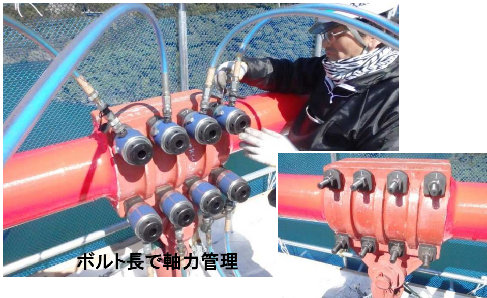
【ボルト取替状況】
