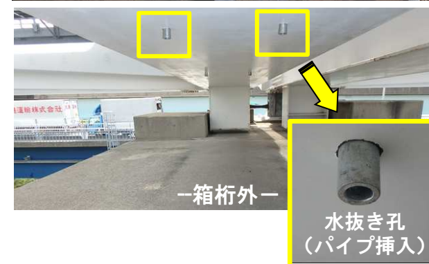
下フランジ滞水防止構造の例
