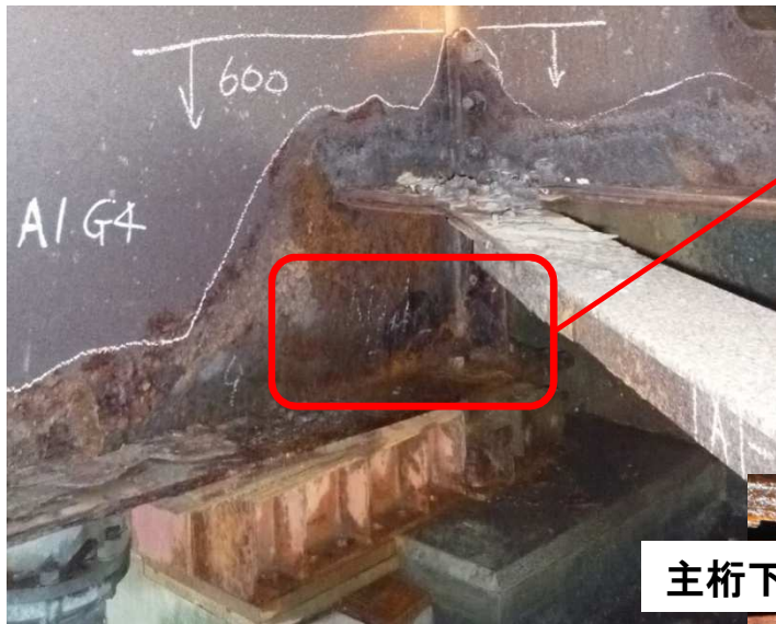
【桁端部の腐食状況】
