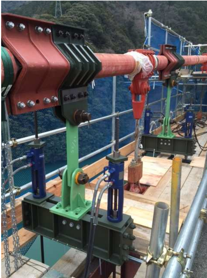
【バイパス材設置(ケーブル側)】
