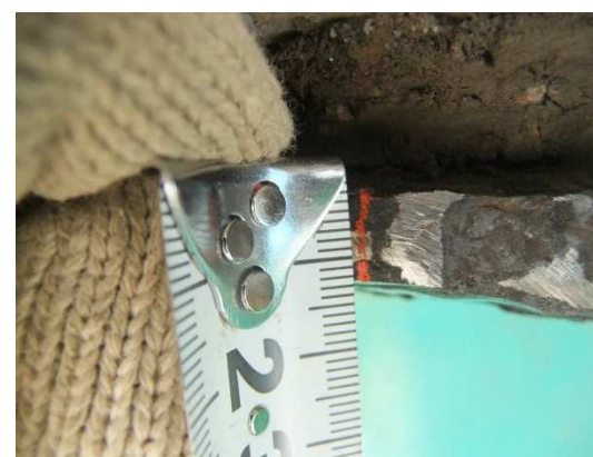
【ケレン後板厚計測】
