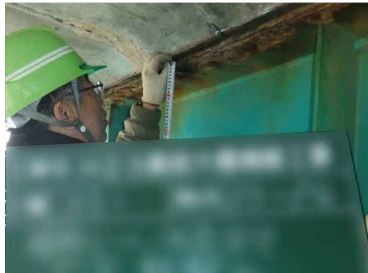
【腐食部調査状況】
