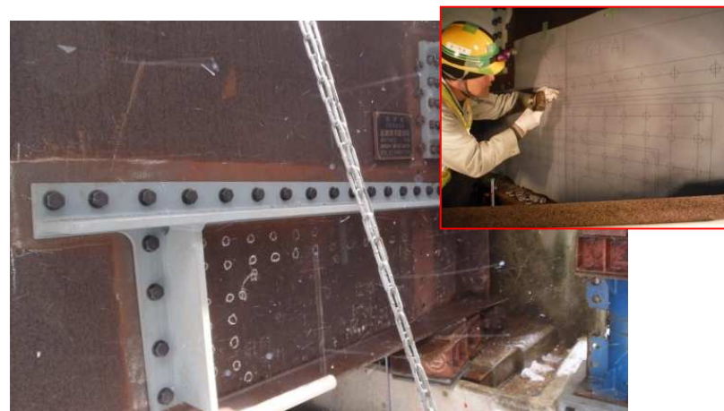
【主桁補強材設置】 （フィルム型による野書き・切断）
