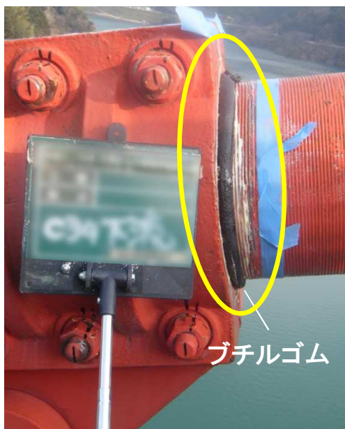
【ブチルゴムとシーリング材による防水処置】
