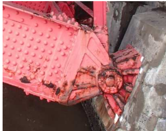
【支承腐食状況】
