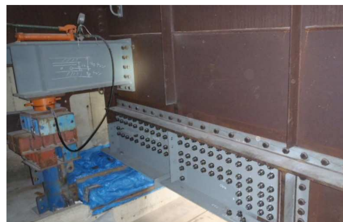
【主桁部材取替え】
