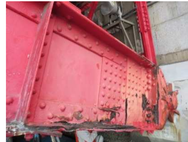
【アーチリブ腐食状況(全景)】
