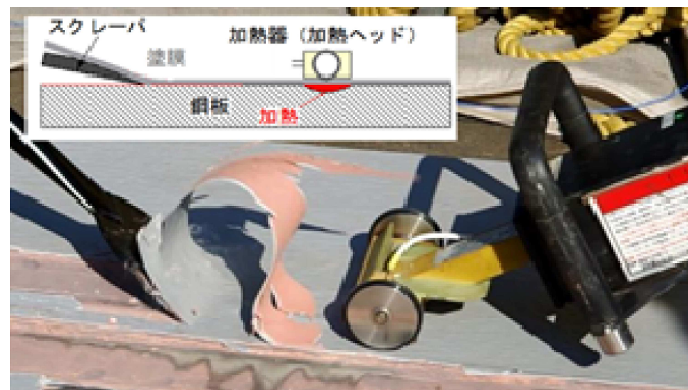
電磁誘導 (IH)工法による塗膜剥離状況
