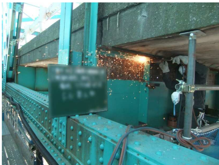
【垂直補強材切断】
