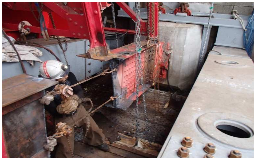
【既設アーチリブ切断・撤去】
