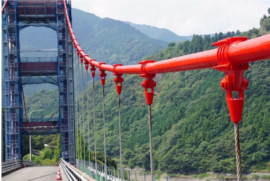
【塗替え塗装状況(外面)】
