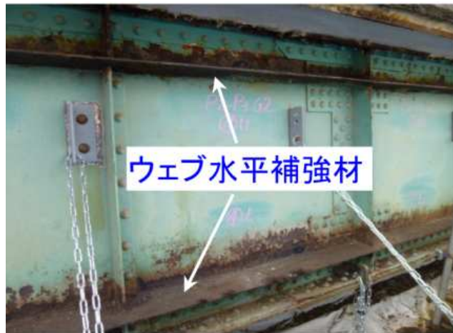
【主桁腹板腐食状況】
