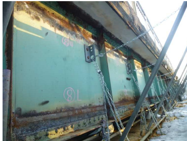
【水平補強材撤去状況完了】
