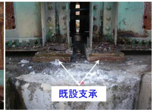
【支点部腐食状況】
