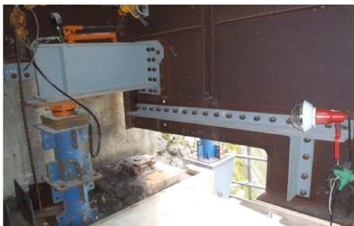
【支承撤去，鋼桁損傷部切断】
