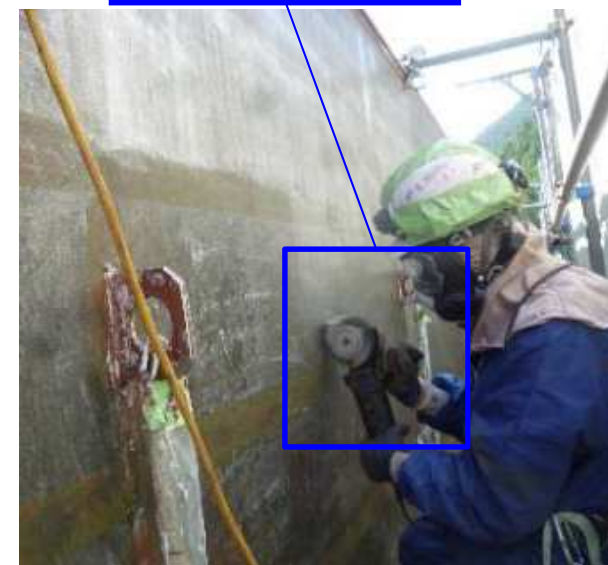
素地調整状況
