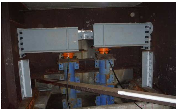
【ジャッキアップブラケット設置】
