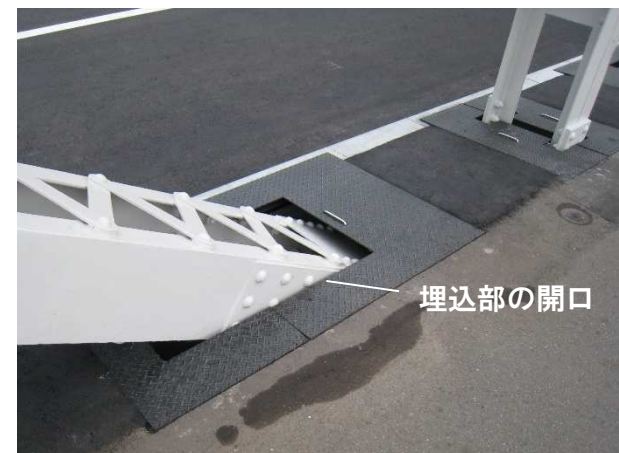
トラス部滞水防止構造の例
