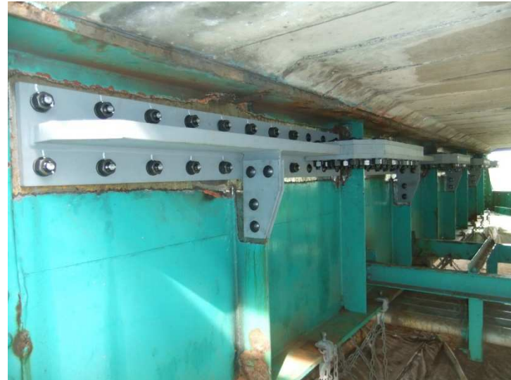
【補強部材取付完了】
