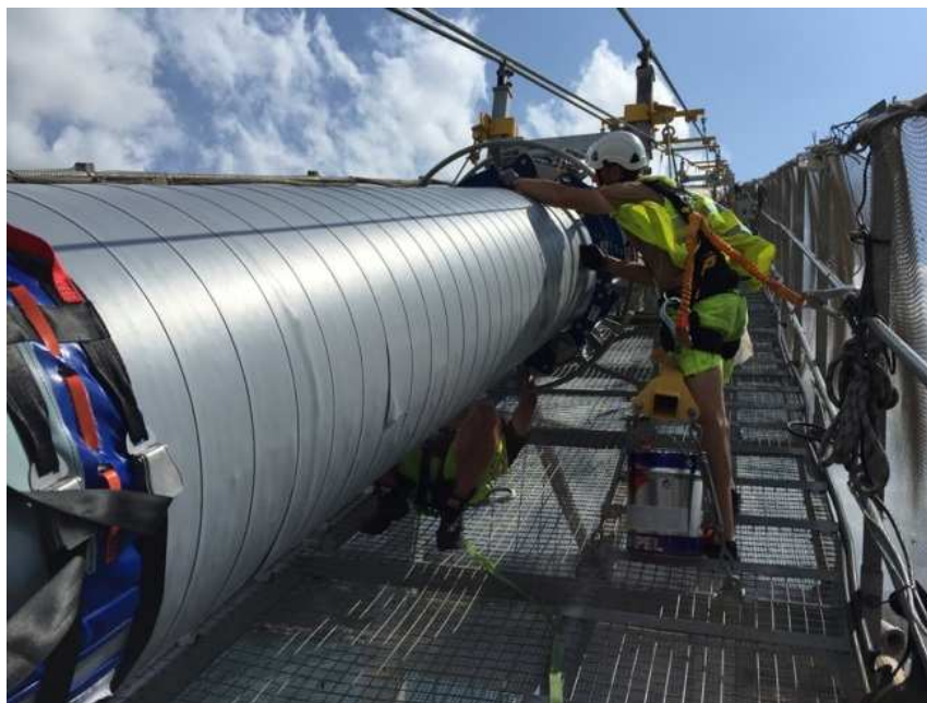
〈弾性材施工状況〉
