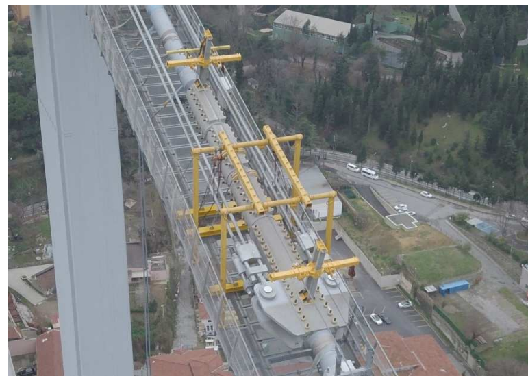
＜補強ストランド用ケーブルバンドー2＞
