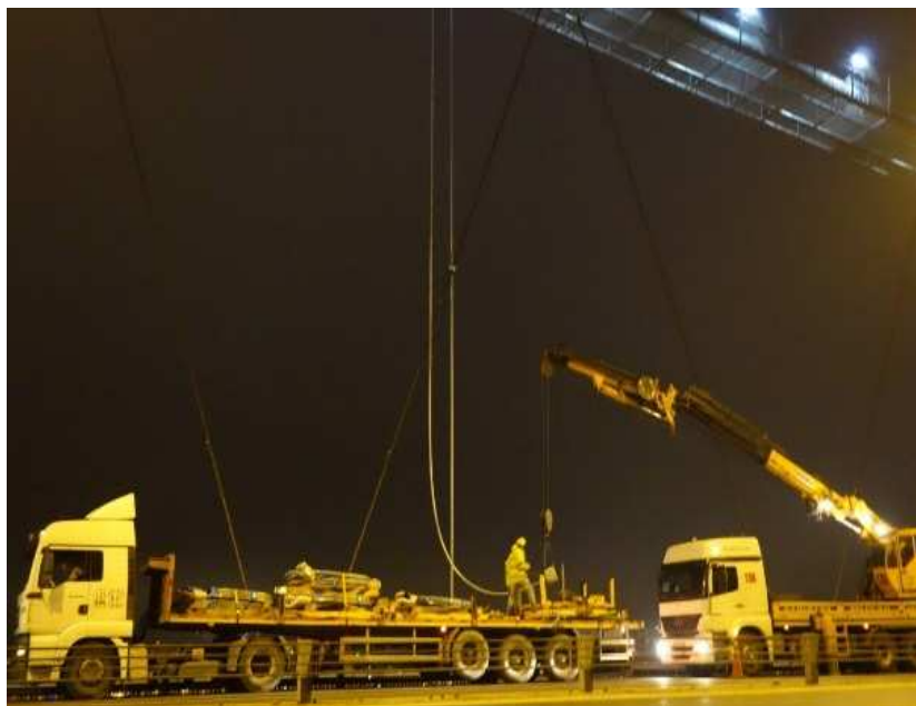
〈夜間架設状況-1〉
