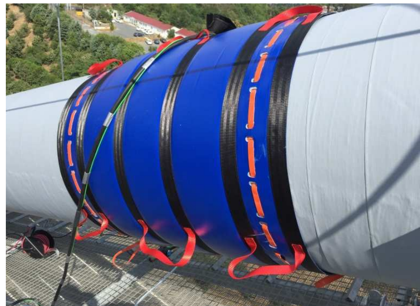
〈ヒートブランケット設置状況〉
