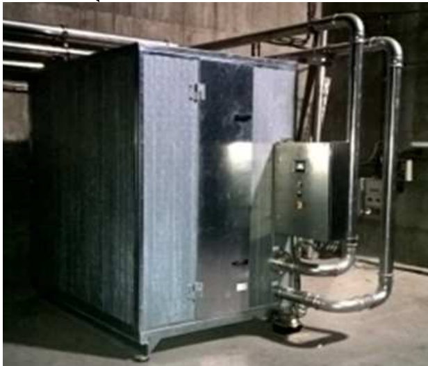
〈橋台内プラントルーム〉
