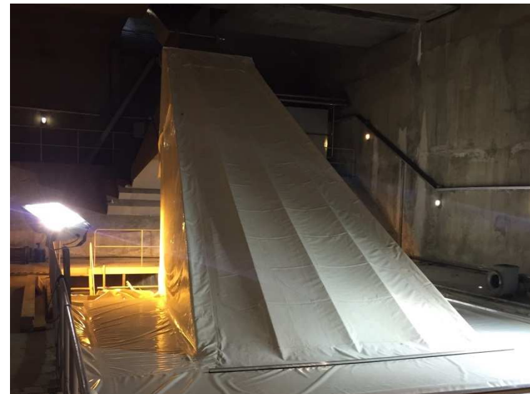
＜橋台内テント設置後＞
