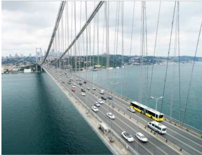
〈斜め・鉛直ハンガー混在状態〉
