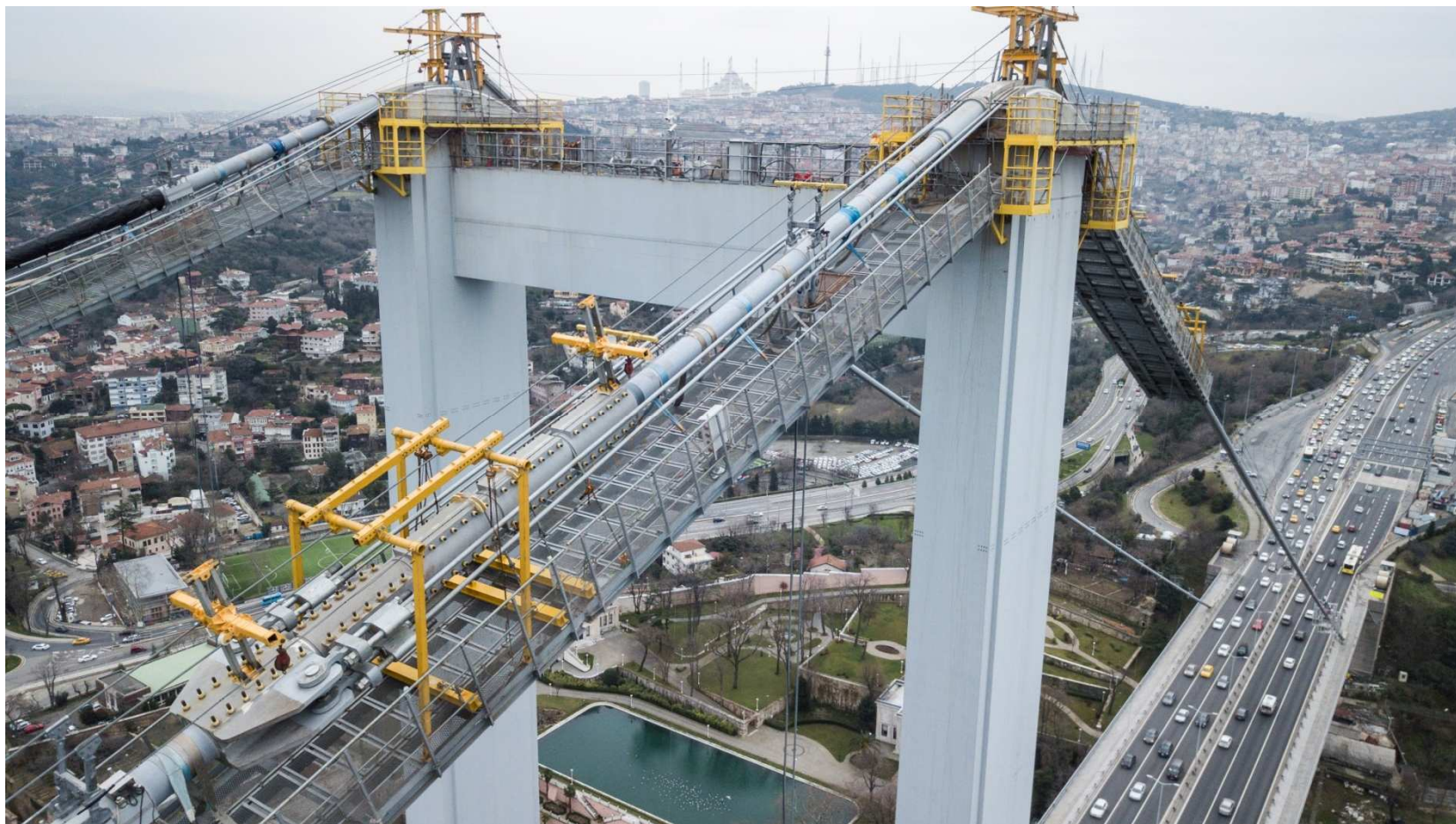
〈主ケーブル補強全景〉
