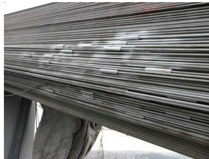
〈補修後の状況〉
