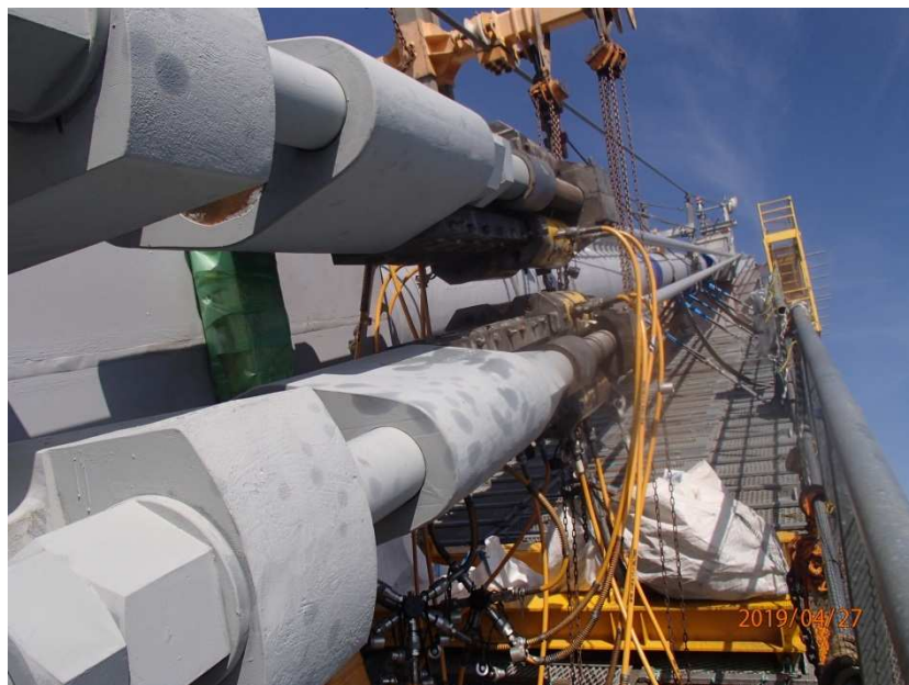
＜ストランド張力導入状況＞
