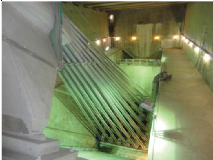
＜橋台内主ケーブルの状態＞
