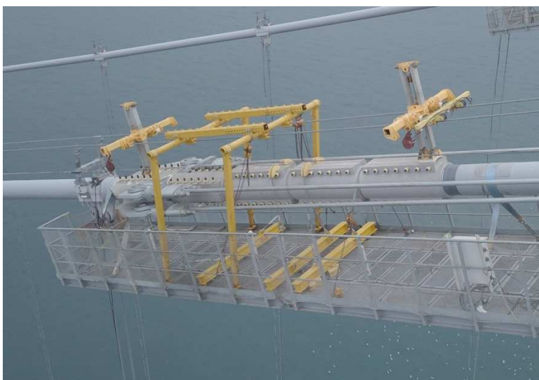
＜補強ストランド用ケーブルバンドー1＞
