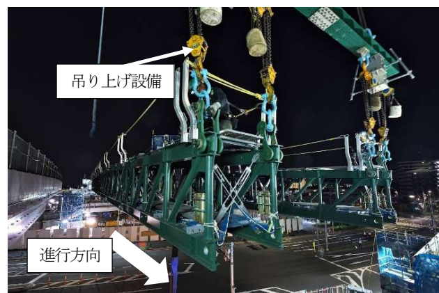
写真-6 手延機先端部吊り上げ状況
