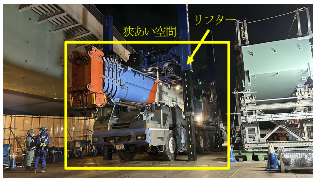
写真－2 リフターを用いたクレーン組立状況
