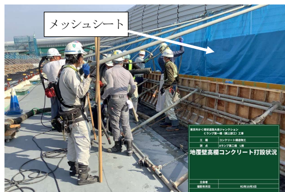
写真-9 側足場養生状況
