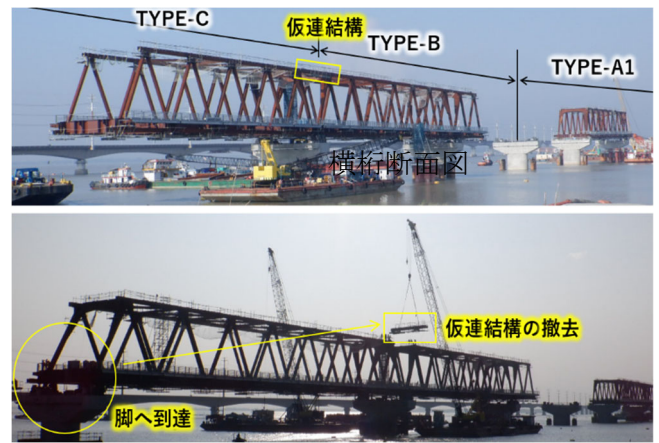
写真 7-9 仮連結構の設置・撤去状況
