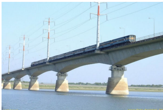
写真 1-1 ジャムナ多目的橋（既設橋）
