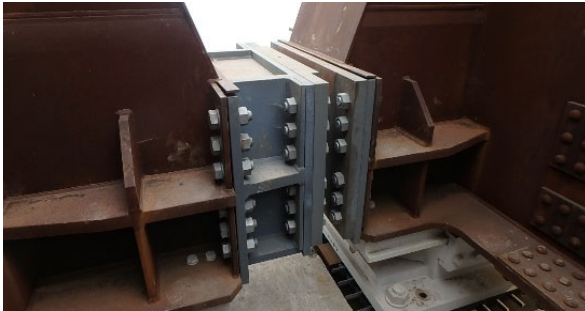
写真 7-10 線支承の設置状況
