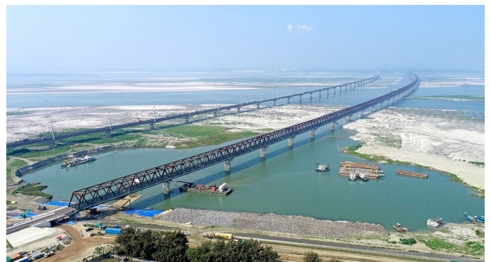
写真 1-2 ジャムナ鉄道専用橋全景（東工区より撮影）
