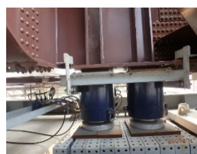
6,000kN ジャッキ (2 台)
