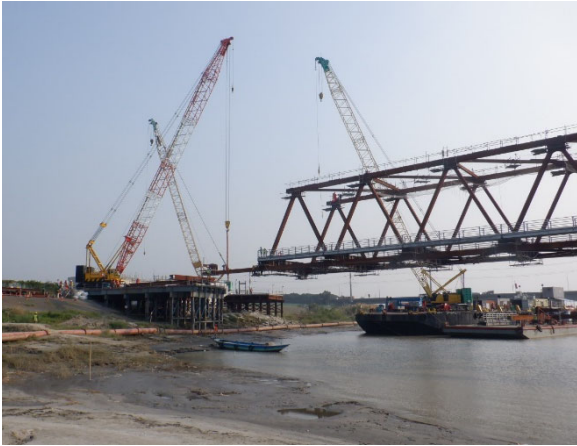
写真 7-7 護岸近傍での架設（東工区）
