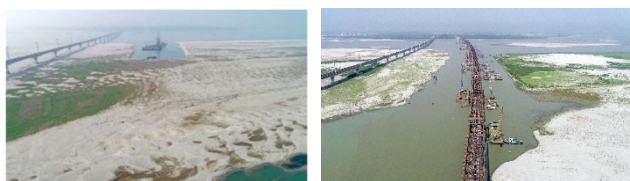
写真 7-6 左：浚渫前(中洲)、右：浚渫後
