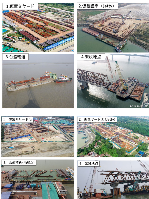
写真7-3 現場内各地点詳細(上：東工区、下：西工区)
