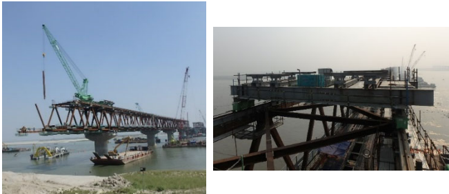
写真 7-8 左：トラベラー架設、右：運搬台車（西工区）
