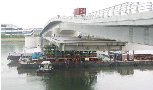
写真-2 多摩川スカイブリッジ通過 (P4～P5)
