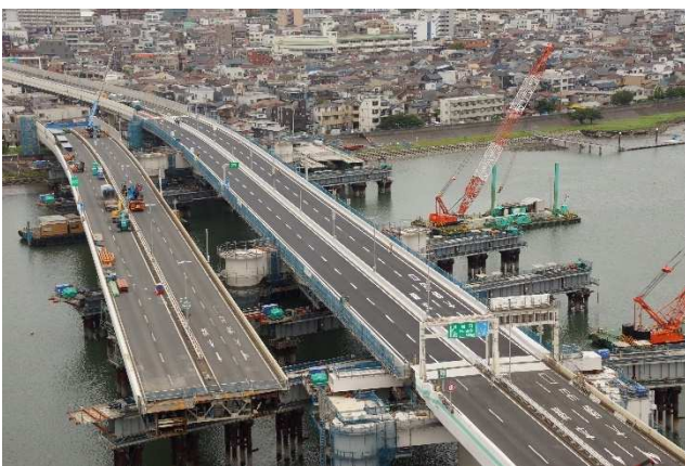
写真-8 通行止め工事完了【提供：首都高速道路（株）】
