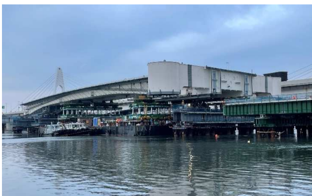
写真-3 リフトアップ架設
