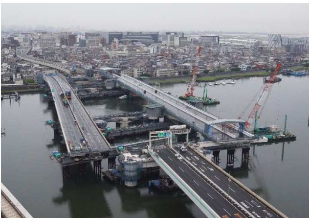
写真-5 既設橋横取り後【提供：首都高速道路(株)】
