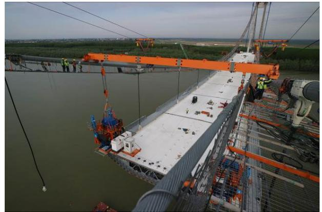
写真-5-5 河川上 直下吊り設備 降下装置
