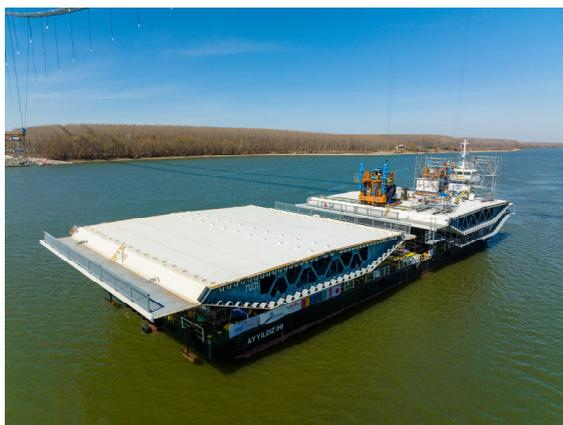
写真-4-2 自航台船による補剛桁の輸送状況
