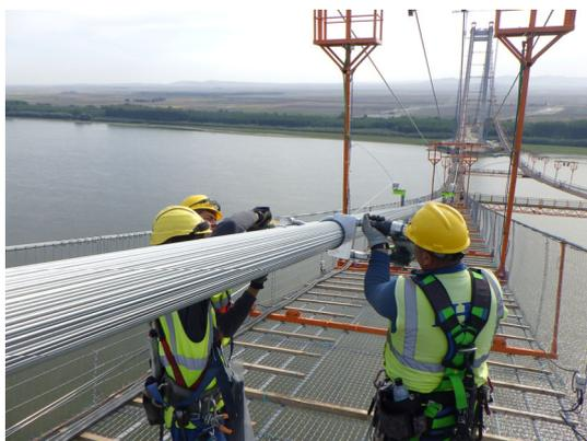
写真-3-9 ストランド締め付け作業状況
