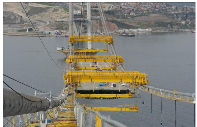
写真-5-4 オスマン・ガーズィー橋 直下吊り設備
