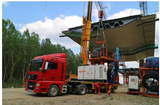
写真-5-6 クレーンによる直下吊り設備の降下
