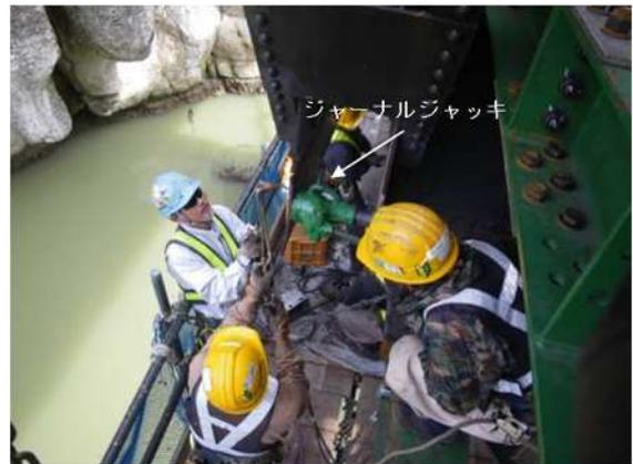
写真-2.3.8 格点ガセットの加熱矯正
