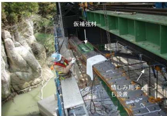
写真-2.3.6 下弦材の切断状況
