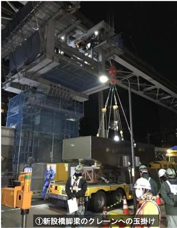
①新設橋脚梁のクレーンへの玉掛け
