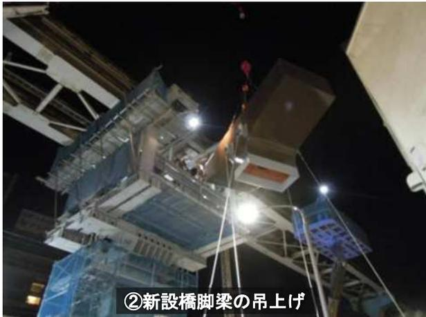
②新設橋脚梁の吊上げ
