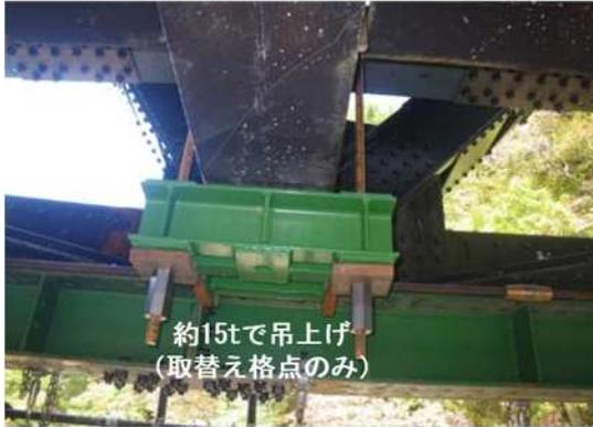
写真-2.3.5 架設桁からの吊上げ設備
