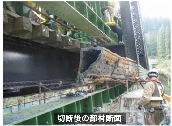
写真-2.3.7 下弦材切断後の状況
