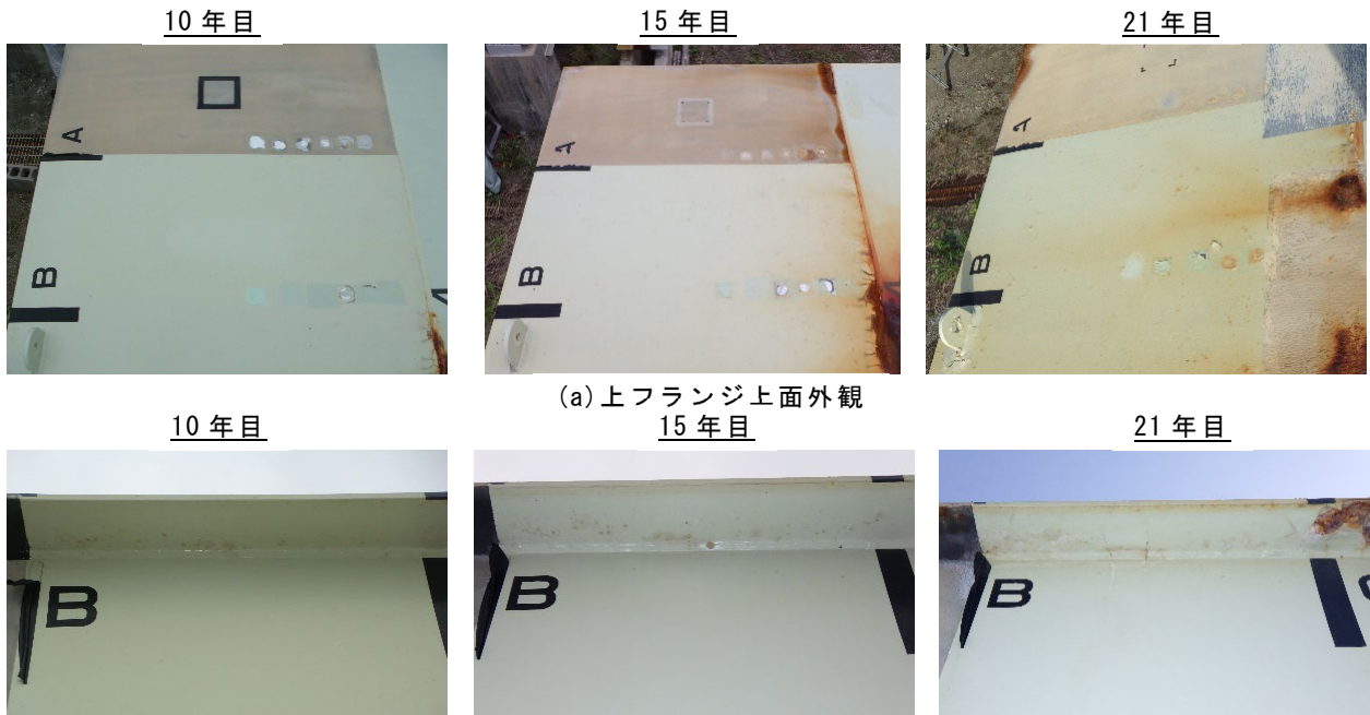
(a)上フランジ上面外観 15年目 (b)上フランジ下面、腹板面外観 21年目 図-10 仕様B 21年目調査
