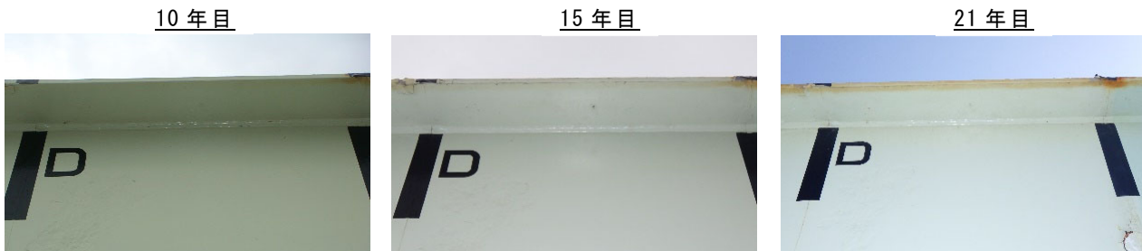
(b) 上フランジ下面、腹板面外観
