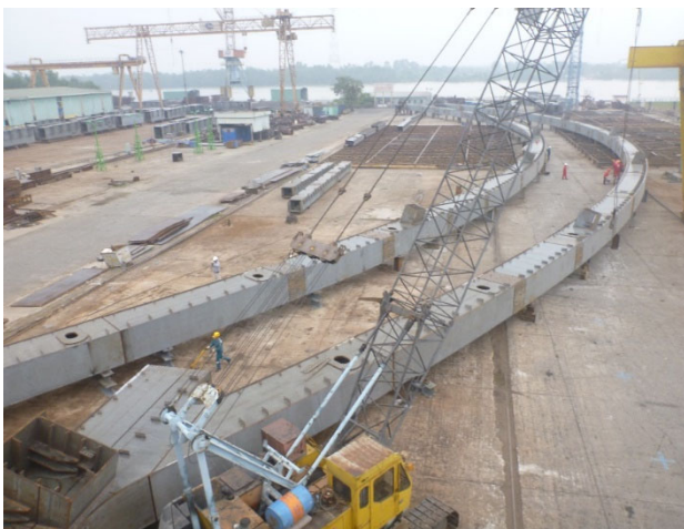
写真-4-4-1 アーチリブの仮組立状況
