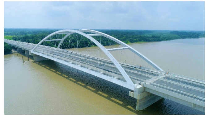
写真-11-2 完成写真
