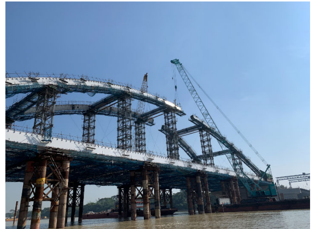
写真-5-3-2 アーチリブの架設-1
