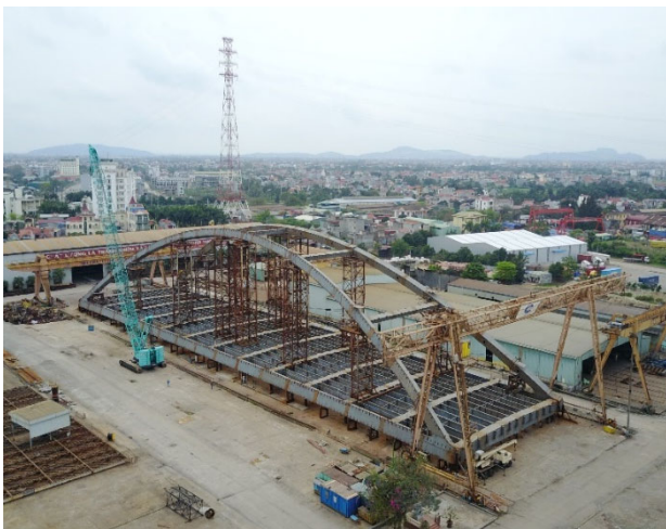
写真-4-4-2 立体仮組立状況
