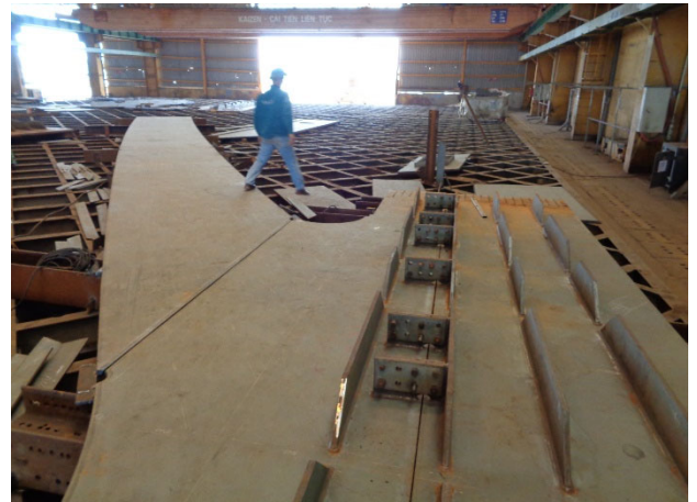
写真-4-3-1 ウェブプレート一体組立
