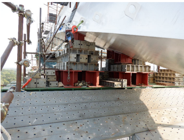
写真-5-3-1 アーチリブのベント受け点
