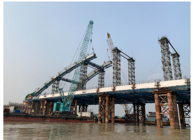
写真-5-3-3 アーチリブの架設-2
