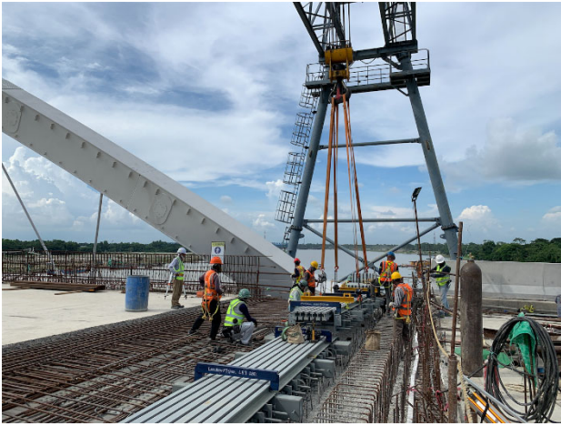
写真-10 伸縮装置の据付け状況
