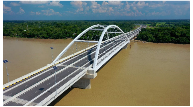
写真-11-1 完成写真
