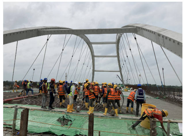
写真-9 床版コンクリート打設状況
