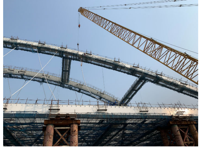
写真-7 ハンガーケーブルの架設
