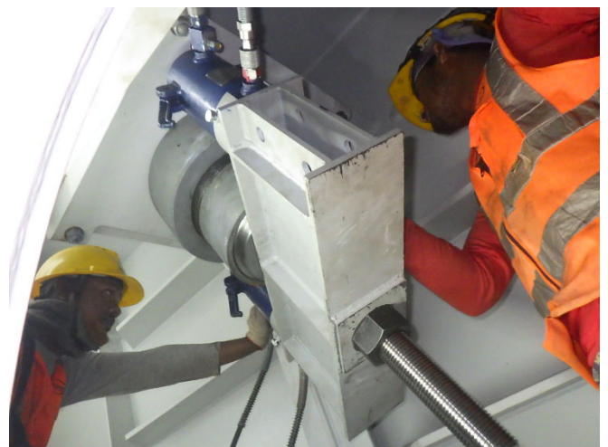
写真-8-2-2 ケーブルの調整
