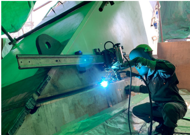
写真-6 現場溶接(アーチリブ)
