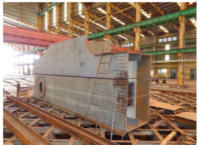
写真-4-3-2 端部現場溶接部の一体組立
