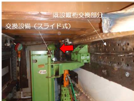
(a) 既設縦桁上フランジ部のスライド、撤去
