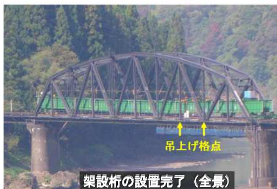
写真-2.3.4 架設桁の設置状況
