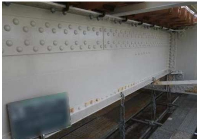
写真-2.2.7 施工完了状況
