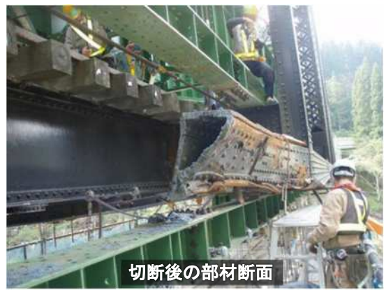
写真-2.3.7 下弦材切断後の状況
