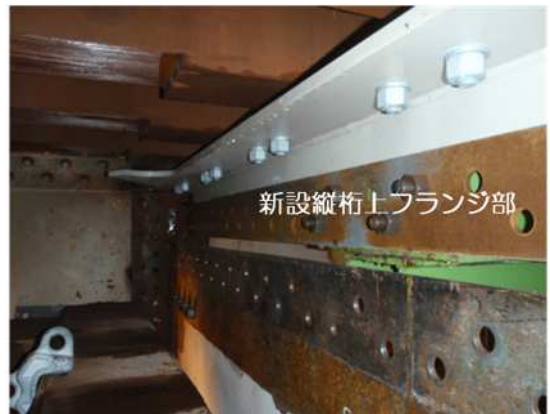
(b) 新設縦桁上フランジ部のスライド、取付け
