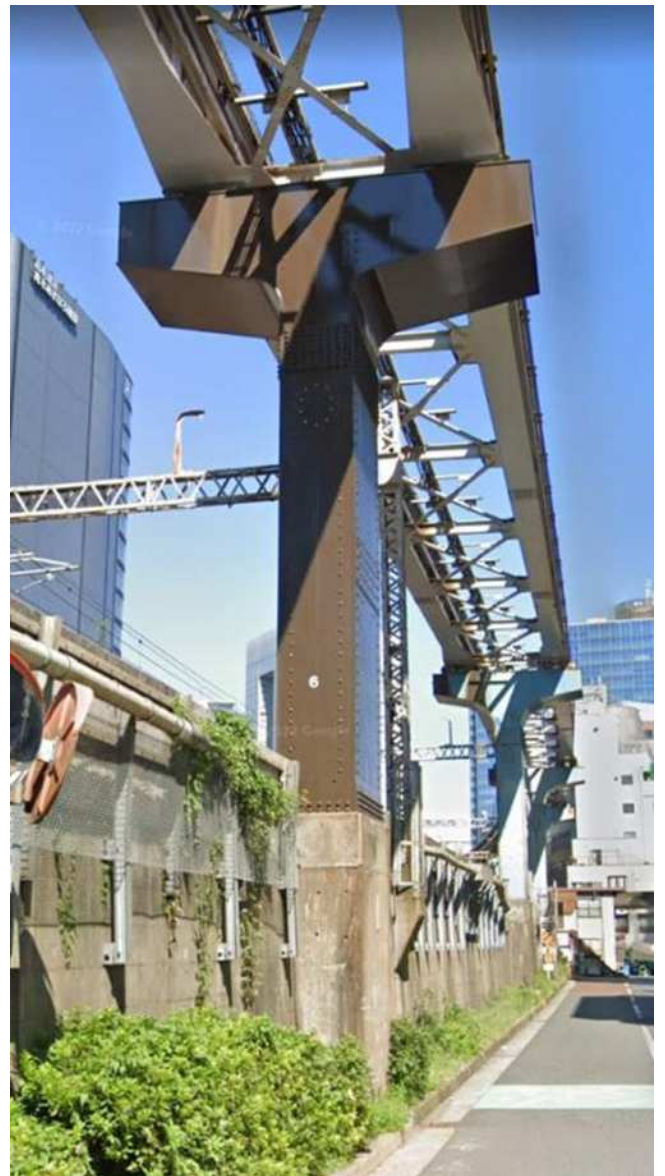
写真-2.1.5 施工完了
