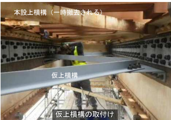
写真-2.2.3 事前作業状況
