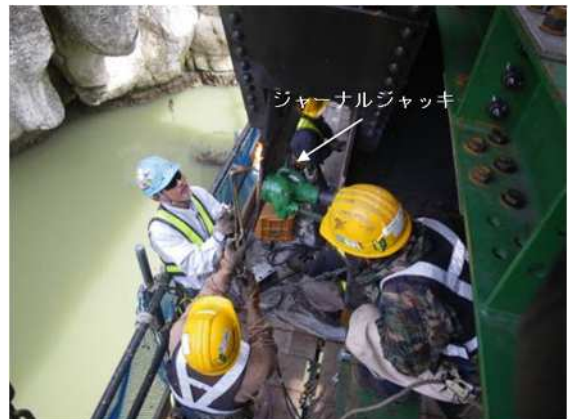
写真-2.3.8 格点ガセットの加熱矯正
