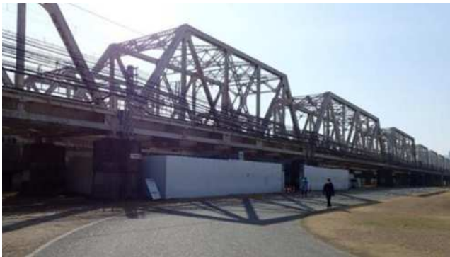
写真-2.2.1 全景写真
