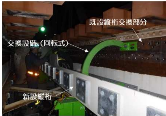
①交換前 (新設側)
