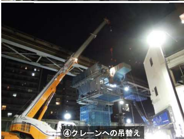
写真-2.1.3 既設脚梁部の撤去状況
