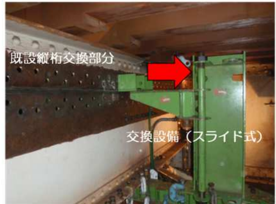
(a) 既設縦桁上フランジ部のスライド、撤去
