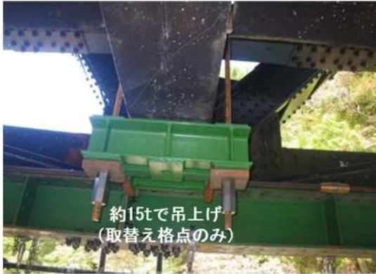
写真-2.3.5 架設桁からの吊上げ設備
