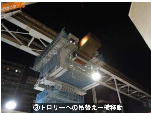
写真-2.1.4 新設脚梁部の架設状況
