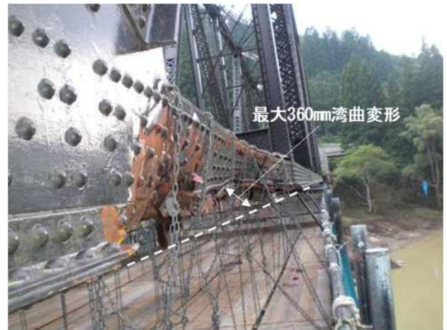
-下弦材の変形状況-
