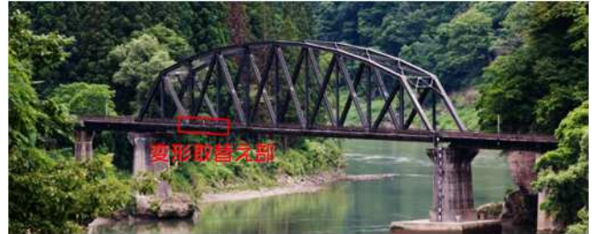
写真-2.3.1 現場全景写真
