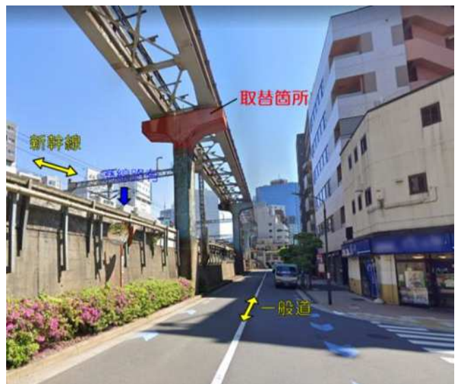
写真-2.1.1 施工箇所周辺状況
