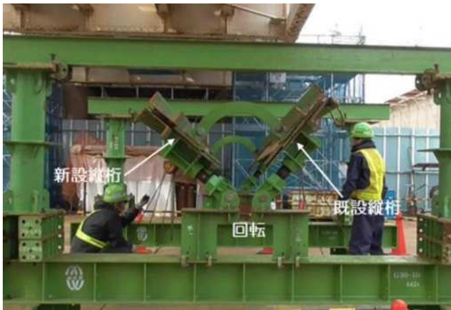
写真-2.2.6 試験施工状況
