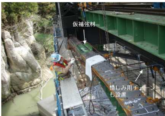
写真-2.3.6 下弦材の切断状況
