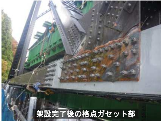
写真-2.3.9 格点ガセット部の新下弦材取付状況
