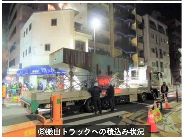
写真-2.1.3 既設脚梁部の撤去状況
