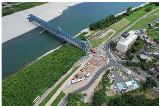
写真-19 送しヤード構築完了
