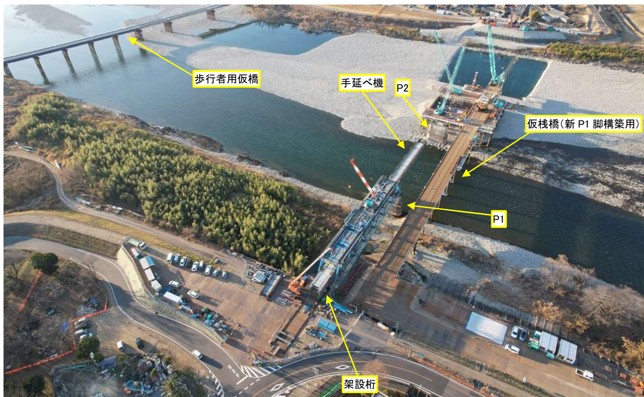
写真-22 A1～P1間 車道桁撤去状況
