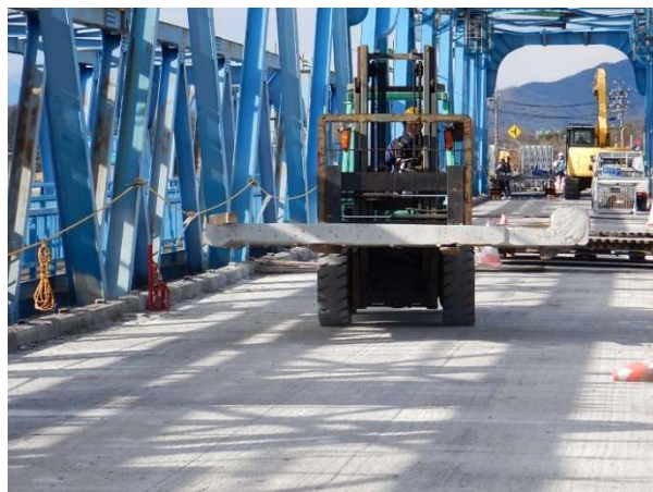
写真-14 RC床版運搬状況
