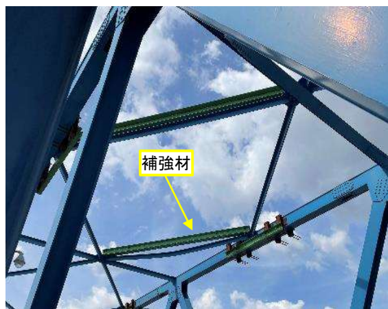
写真-6 横構補強材取付状況
