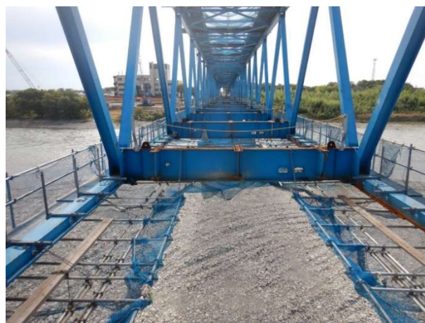
写真-25 縦桁撤去完了状況
