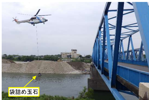
写真-3 袋詰め玉石根固め状況
