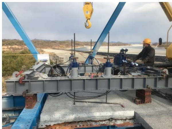
写真-13 RC床版引き剥がし状況
