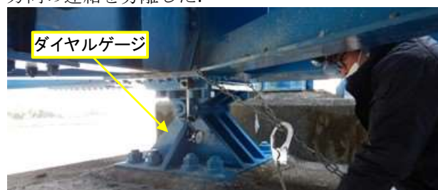
写真-8 ダイヤルゲージ設置状況
