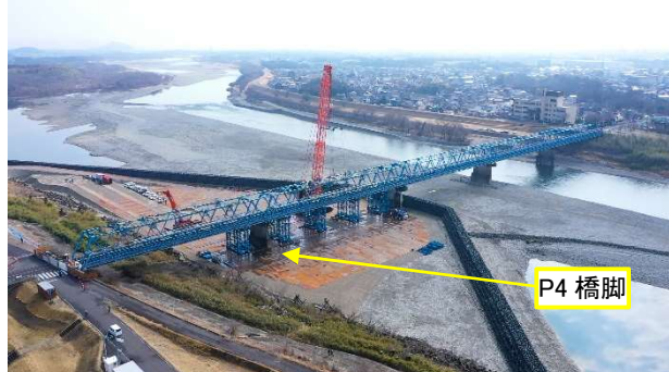
写真-7 右岸側瀬替え状況
