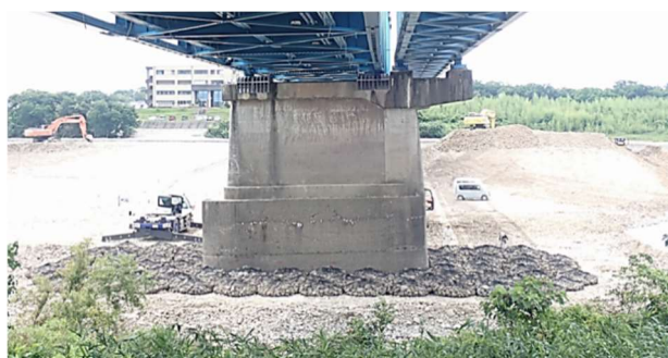
写真-5 P4橋脚根固め完了状況
