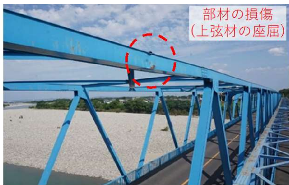
図-2 橋梁全体の損傷状況
