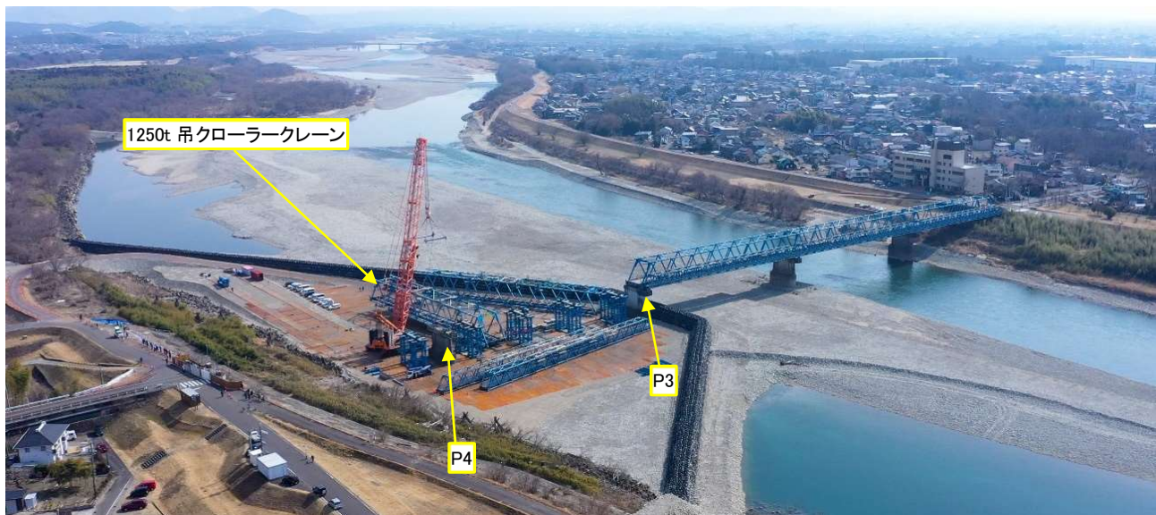
写真-16 P3～A2間大ブロック一括撤去状況
