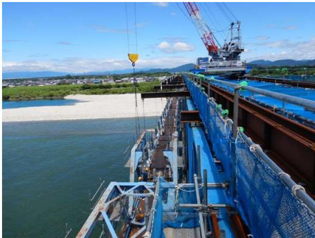
写真-20 歩道桁撤去状況
