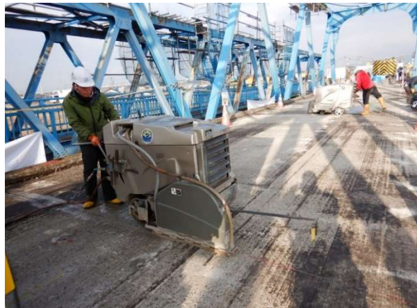
写真-12 RC床版切断状況（道路カッター）
