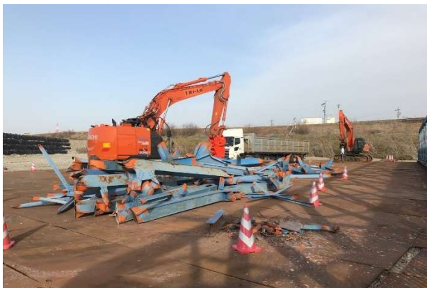
写真-17 鋼桁切断状況
