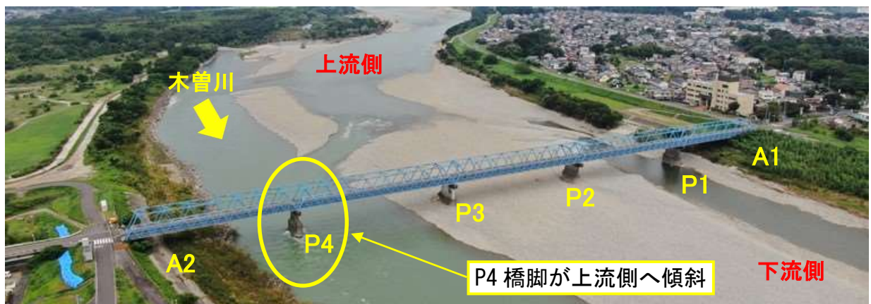
写真-1 川島大橋撤去前全景
