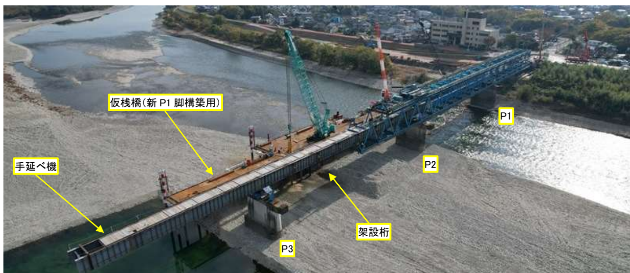
写真-23 P2～P3間 車道桁撤去状況
