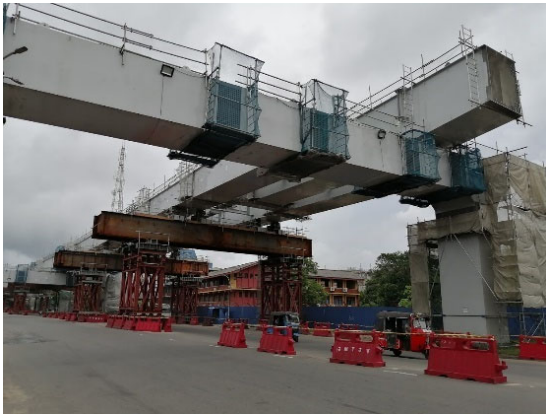
写真 6-1 門型ベント設置状況
