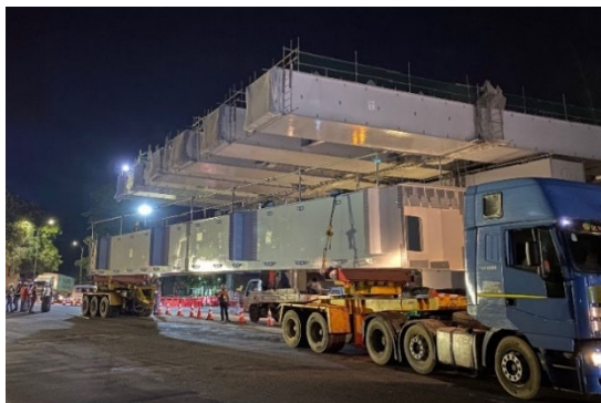
写真6-5 地組ブロックの輸送状況
