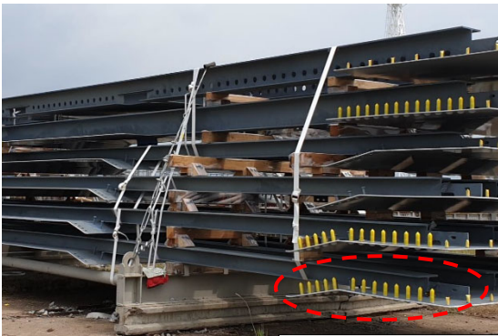
写真5-1 ワンサイドボルト設置状況
