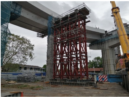
写真 6-2 ベント設置状況
