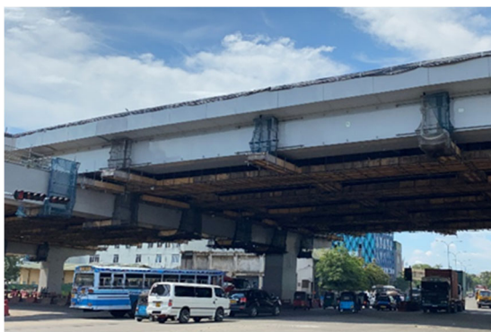
写真5-2 張り出し部の足場状況
