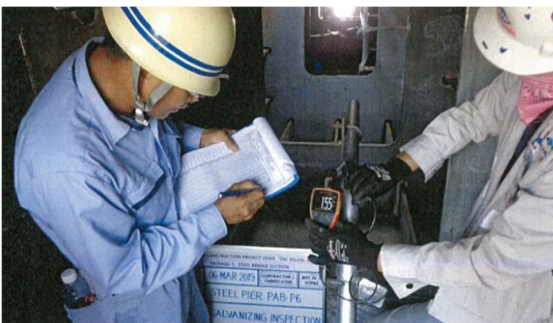
写真4-3 日本人技師による立会検査状況
