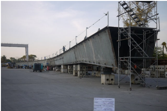
写真 4-7 ランプ橋仮組立状況
