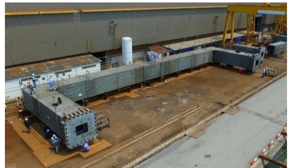
写真4-5 橋脚の仮組立状況
