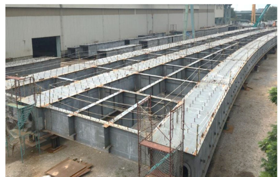
写真4-6 上部工の仮組立状況
