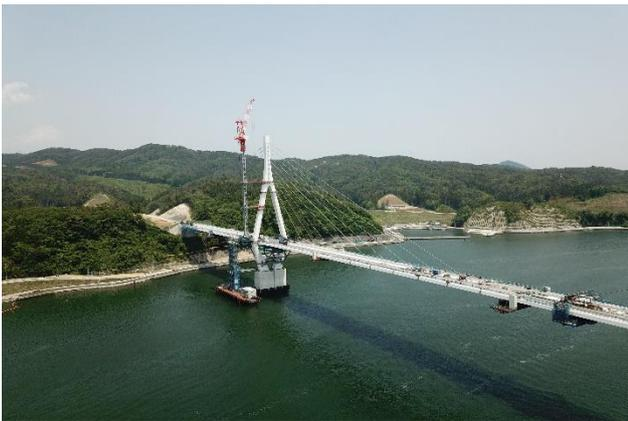
写真-12 主桁閉合完了
