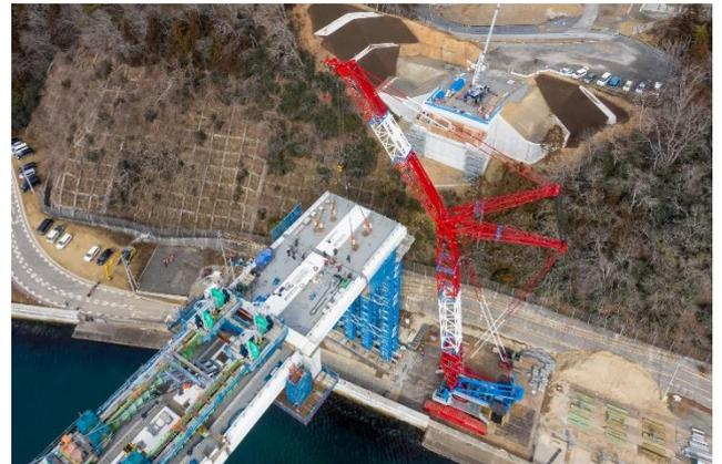
写真-9 陸上部主桁ブロック架設状況
