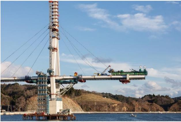
写真-6 ケーブル架設状況
