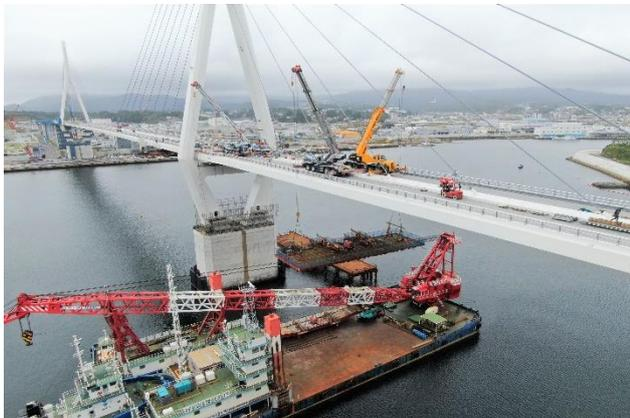
写真-18 移動防護工解体状況
