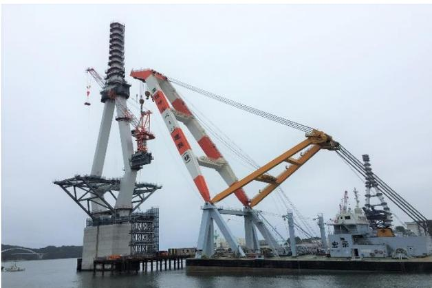
写真-13 クライミングクレーン設置状況
