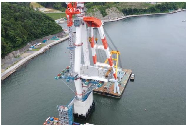
写真-4 主桁大ブロック架設状況
