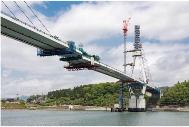
写真-11 主桁閉合ブロック架設完了
