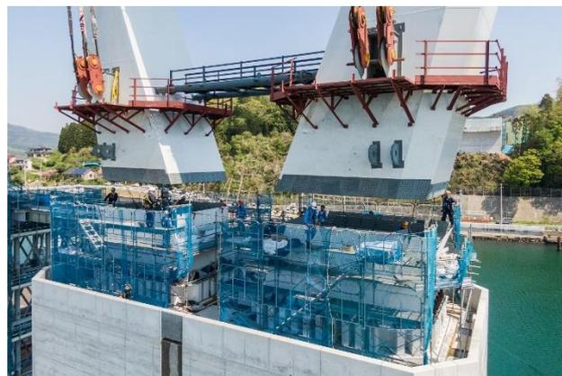
写真-2 主塔基部・下段ブロック接合状況
