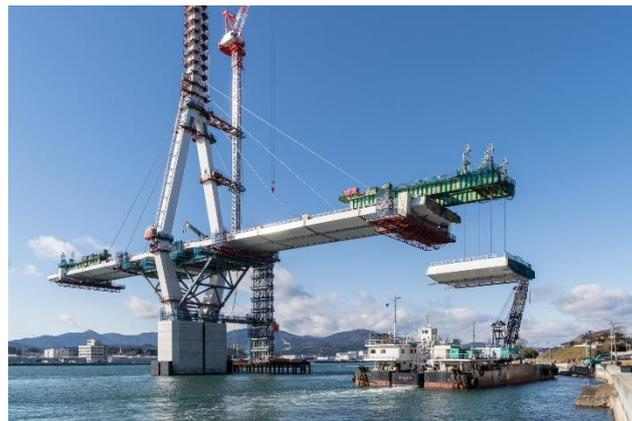
写真-5 主桁ブロック吊上げ架設状況
