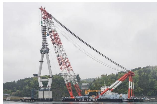
写真-3 主塔上段ブロック架設状況
