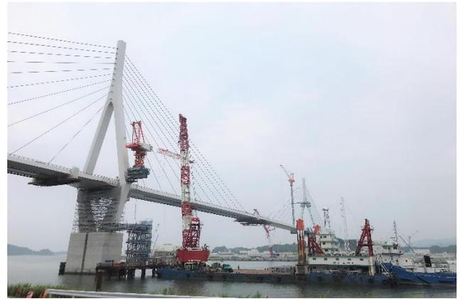
写真-14 クライミングクレーン解体状況
