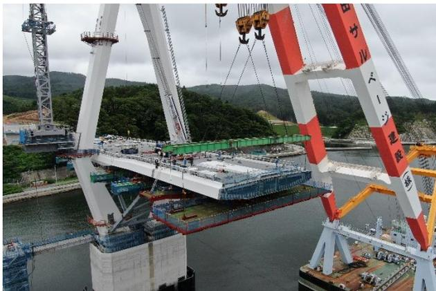
写真-17 移動防護工設置状況
