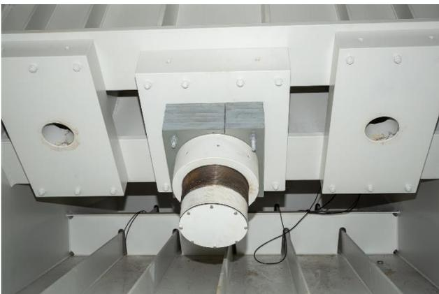
写真-8 ケーブルソケット定着（桁側）
