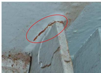
さびによる変色や塗膜割れにより、疲労き裂やき裂長さが検出可能。
