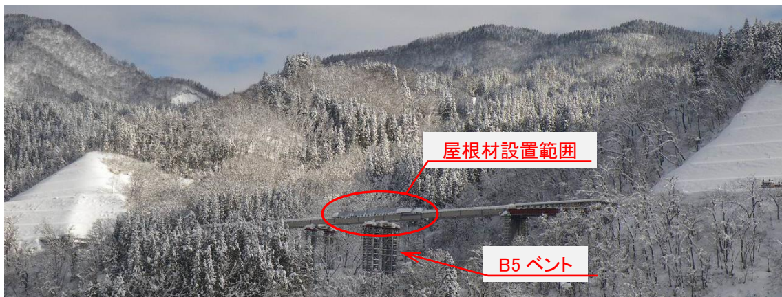
写真 送り出し架設後の越冬状況（冬期休工期間の様子）（ppt_17 頁掲載写真）
