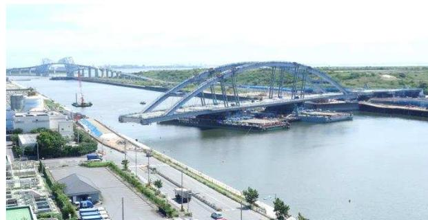
写真—7 台船旋回前（上段）旋回後（下段）
