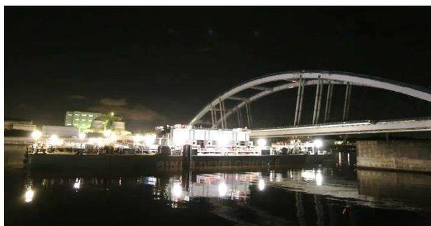
写真—10 一括架設後 台船退出状況
