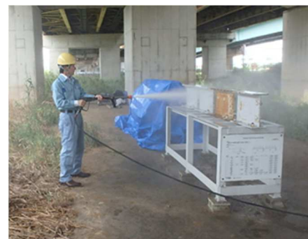
写真-3.2 洗浄状況
