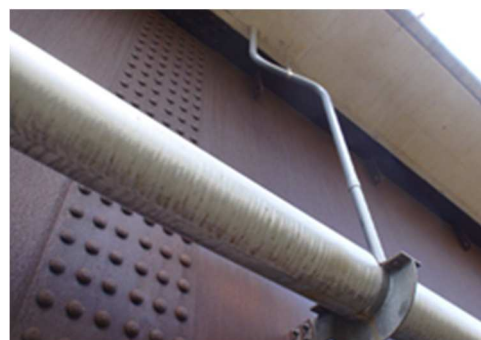
写真-4.3 導水管設置状況
