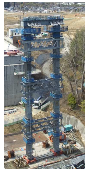
a) A1 側斜吊り鉄塔
