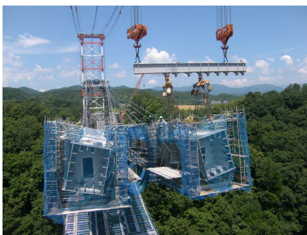
写真-9 アーチリブ架設状況（近景）
