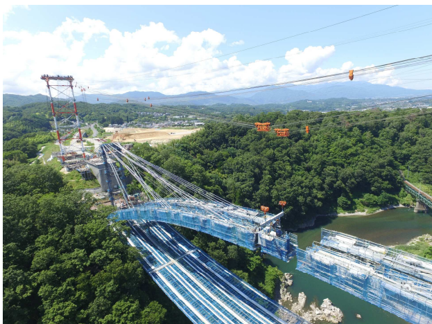
写真-8 アーチリブ架設状況（遠景）
