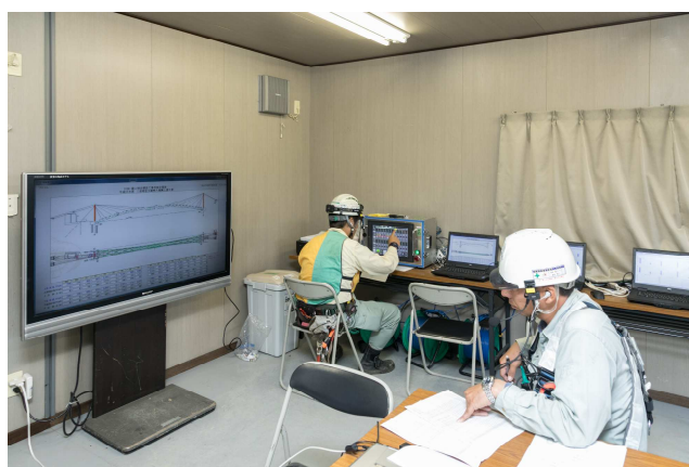
写真-6 斜吊り索集中管理操作室
