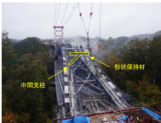
写真-7 中間支柱の架設
