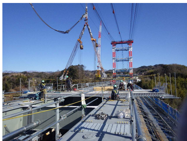
写真-10 床版パネル架設状況
