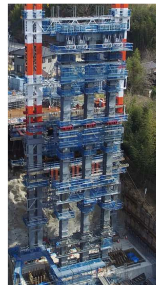
b) A2 側斜吊り鉄塔
